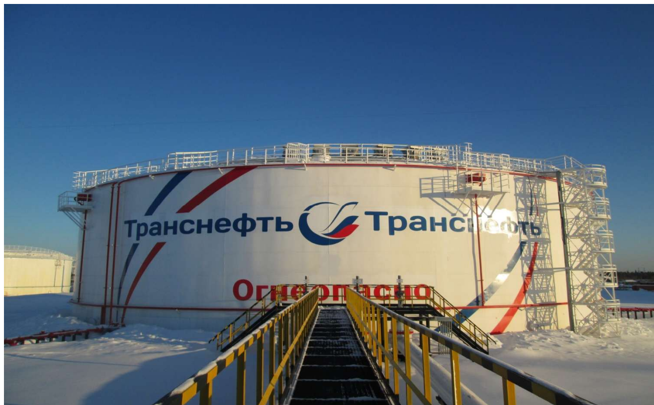
Рисунок 3 - Общий вид резервуара вертикального стального цилиндрического РВС-20000
