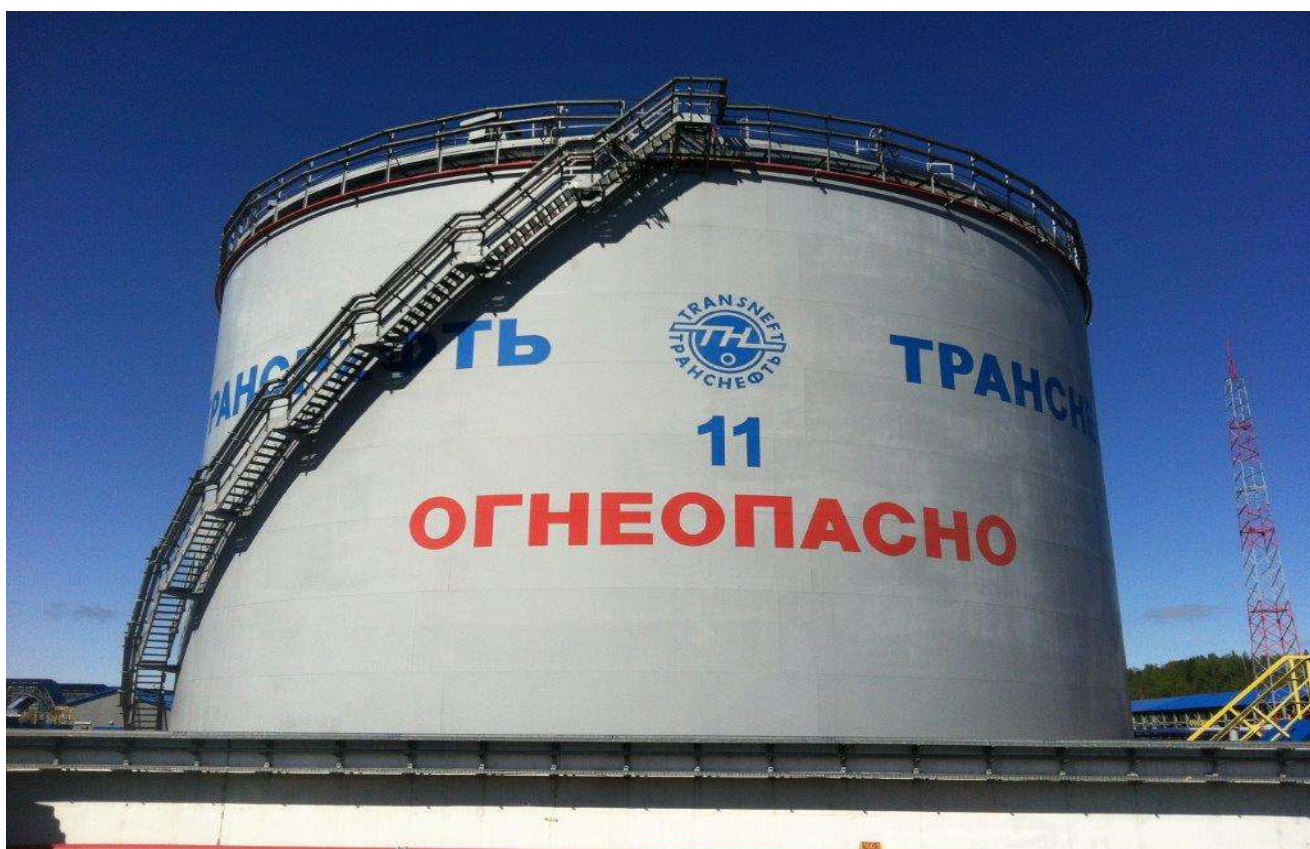
Рисунок 2 - Общий вид резервуара вертикального стального цилиндрического РВС-10000
