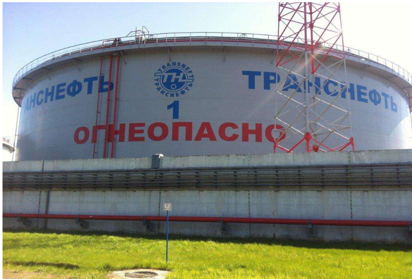
Рисунок 4 - Общий вид резервуара вертикального стального цилиндрического РВСПК-50000
