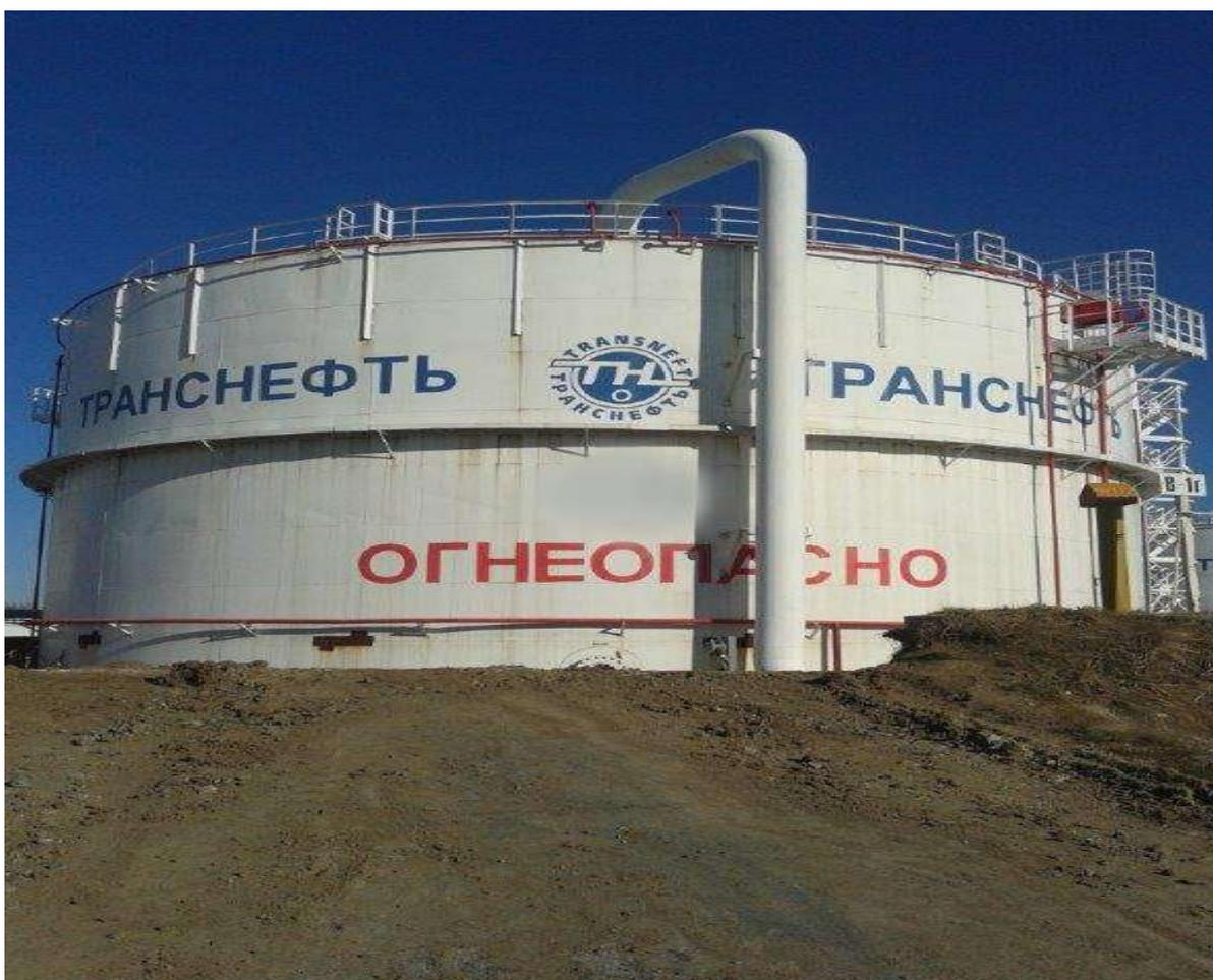
Рисунок 1 - Общий вид резервуара вертикального стального цилиндрического РВС-5000
