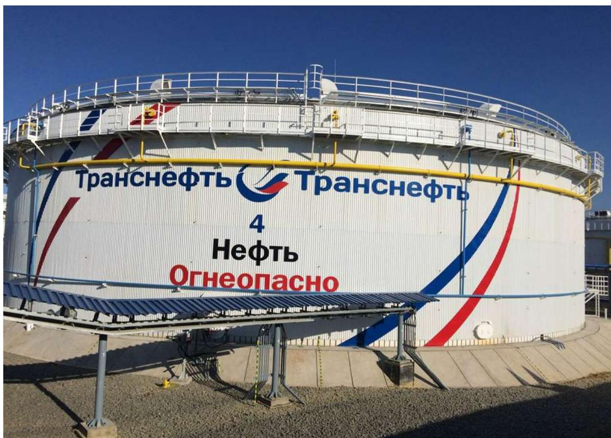
Рисунок 2 - Общий вид резервуара вертикального стального цилиндрического РВСП-20000
