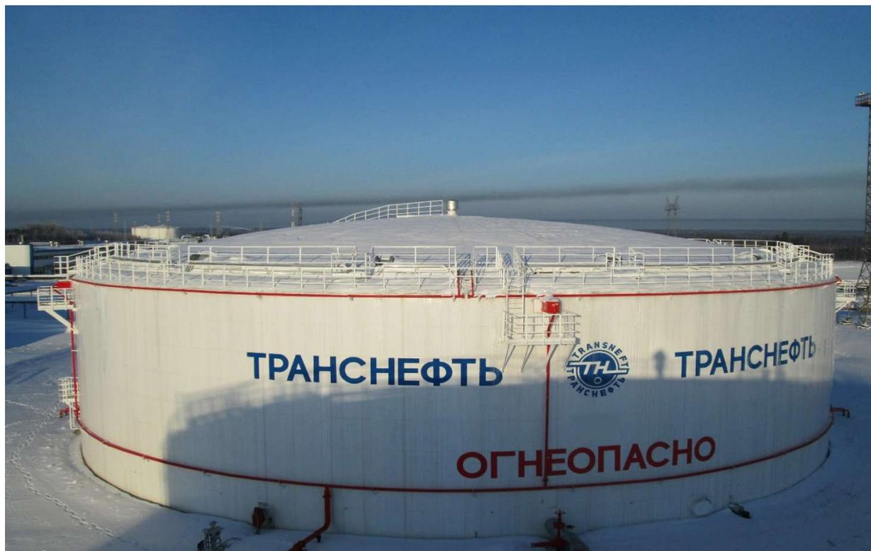
Рисунок 3 - Общий вид резервуара вертикального стального цилиндрического РВСП-50000
