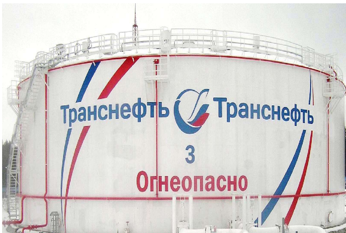
Рисунок 3 - Общий вид резервуара вертикального стального цилиндрического РВСП-20000
