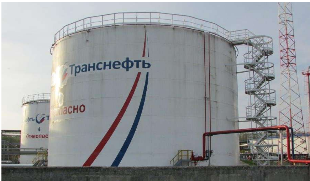
Рисунок 2 - Общий вид резервуара вертикального стального цилиндрического РВС-3000
