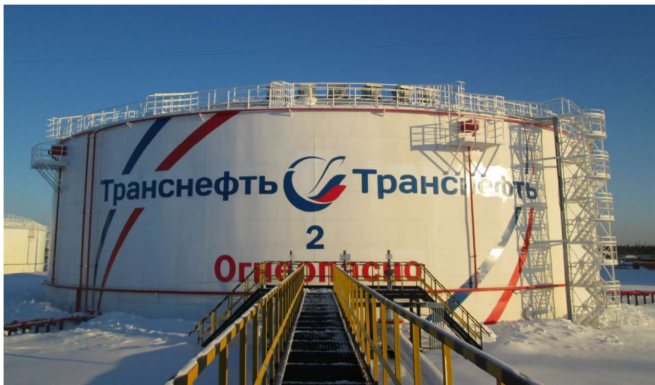
Рисунок 6 - Общий вид резервуара вертикального стального цилиндрического РВС-20000
