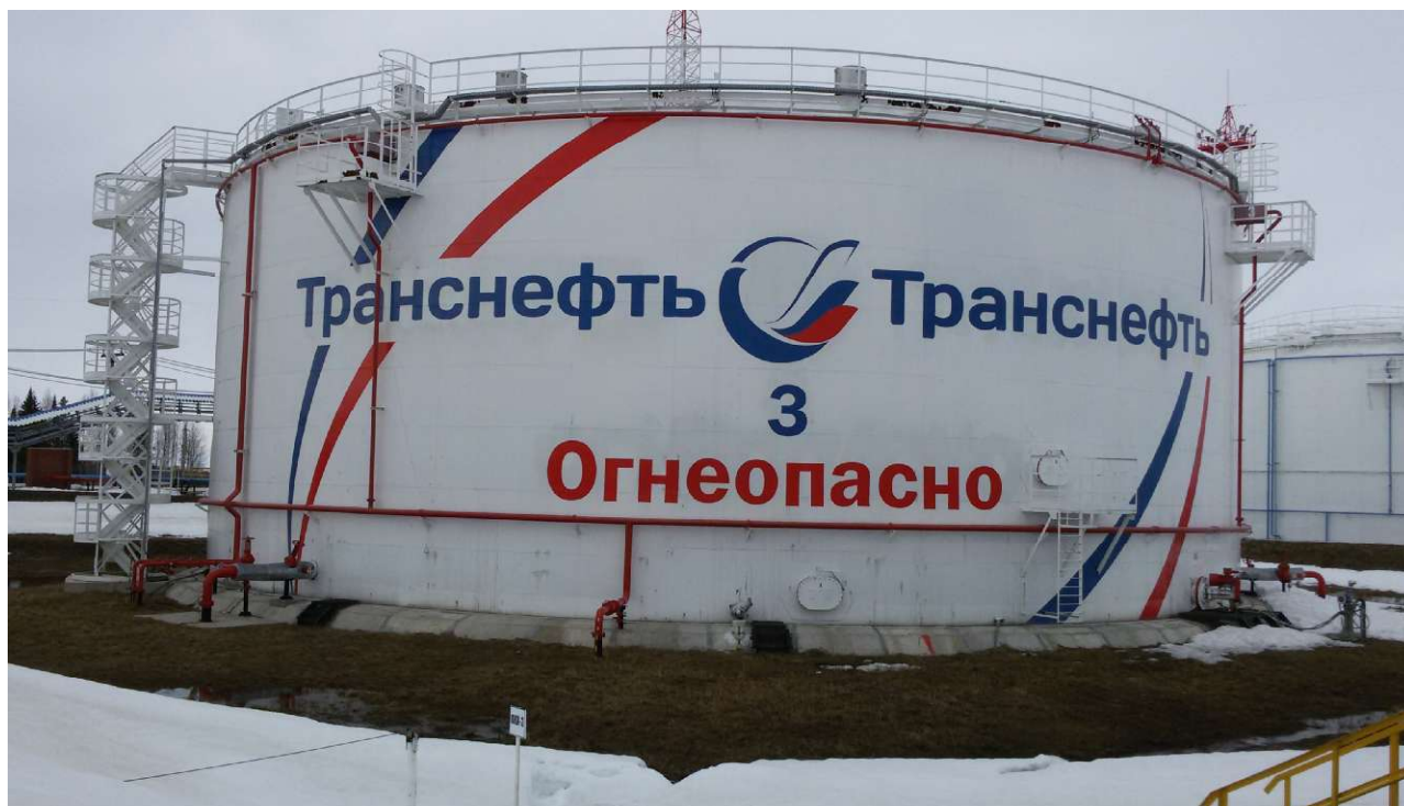
Рисунок 5 - Общий вид резервуара вертикального стального цилиндрического РВСП-10000
