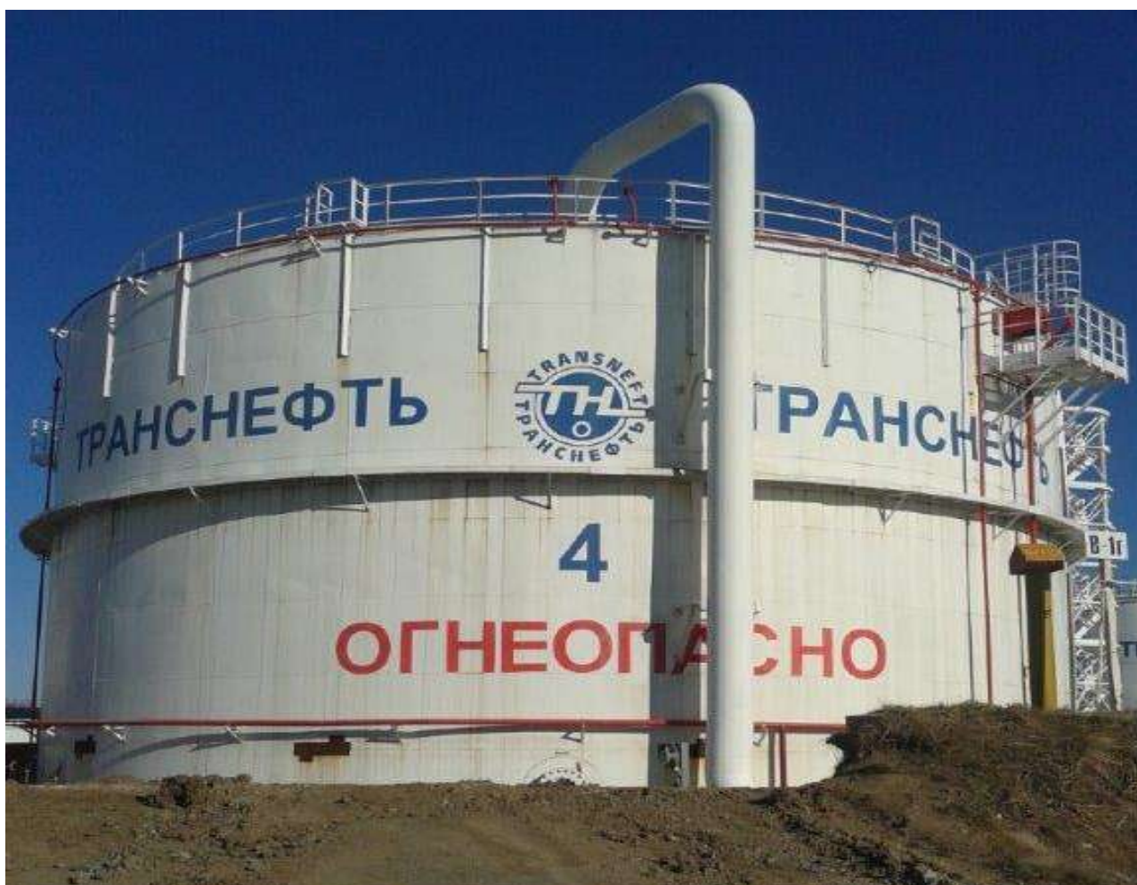
Рисунок 3 - Общий вид резервуара вертикального стального цилиндрического РВС-5000
