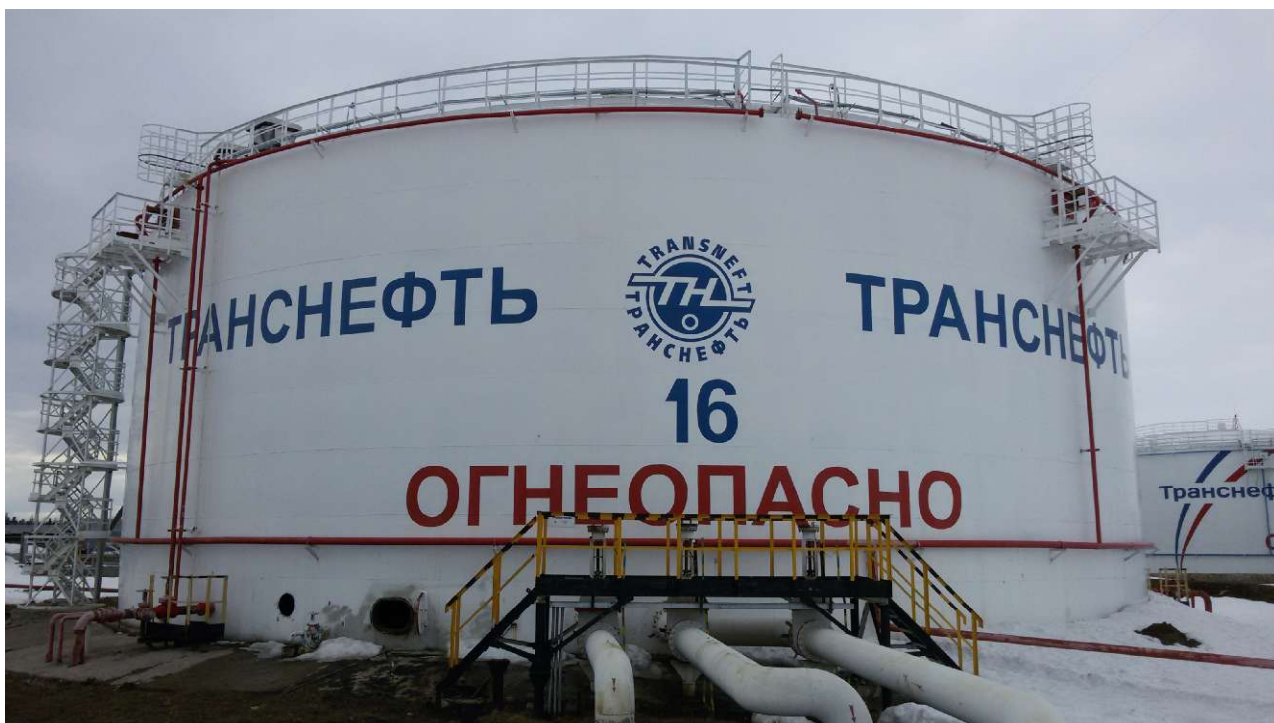
Рисунок 4 - Общий вид резервуара вертикального стального цилиндрического РВС-10000
