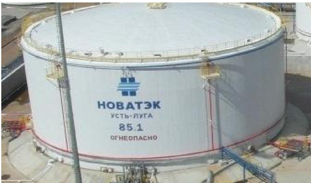
Рисунок 1 - Общий вид резервуара стального вертикального с понтоном РВСП-30000
