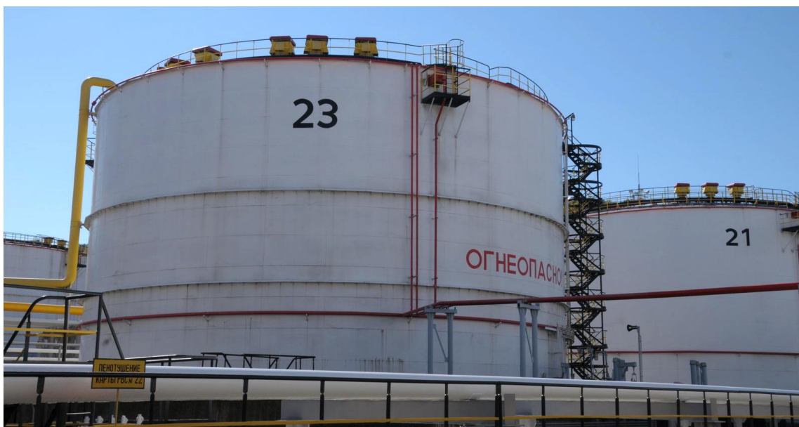
Рисунок 1 - Общий вид резервуаров
