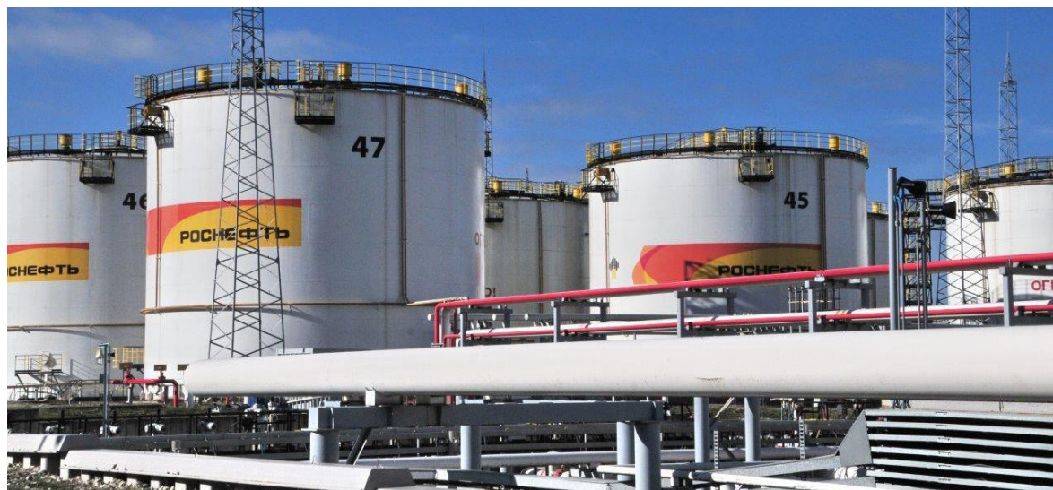
Рисунок 1 - Общий вид резервуаров
