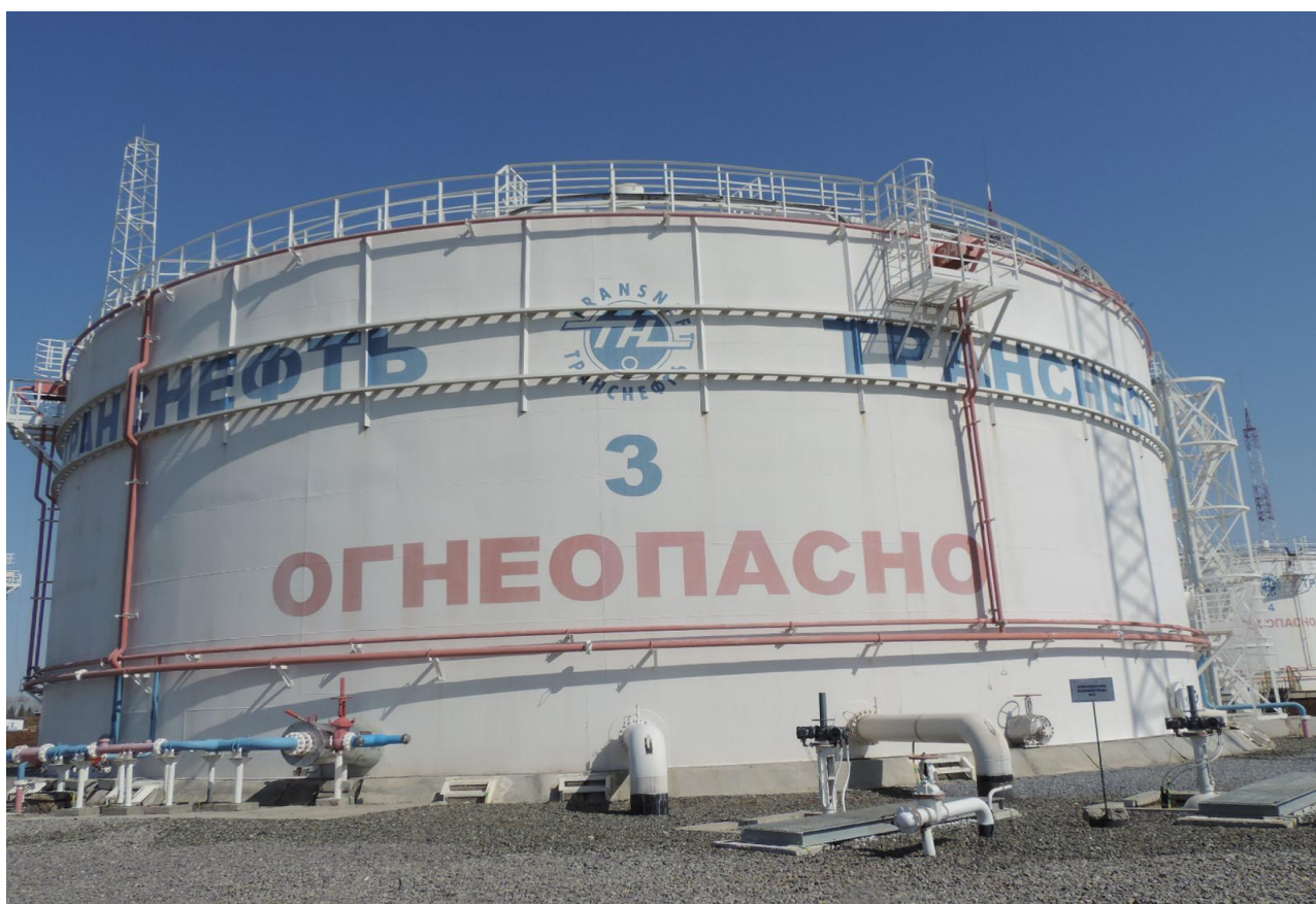
Рисунок 7 - Общий вид резервуара вертикального стального цилиндрического РВСП-10000
