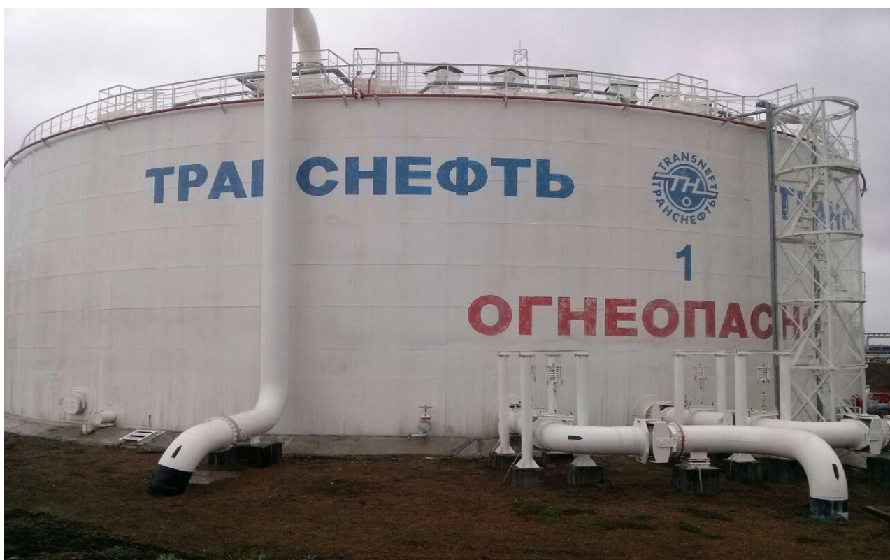
Рисунок 8 - Общий вид резервуара вертикального стального цилиндрического РВС-20000
