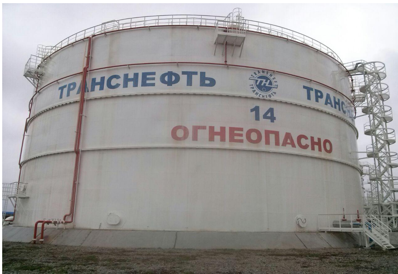
Рисунок 9 - Общий вид резервуара вертикального стального цилиндрического RVSP-20000
