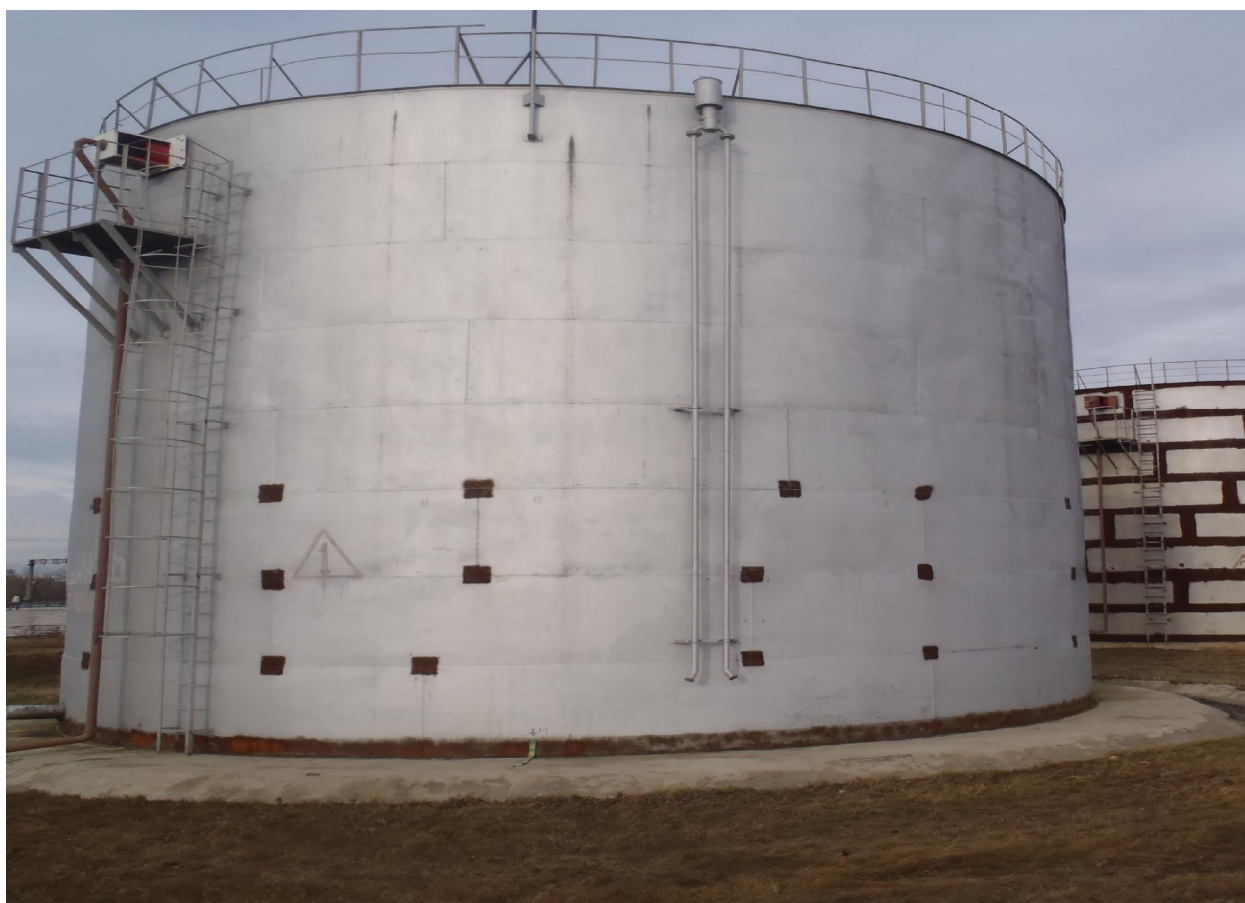
Рисунок 3 - Общий вид резервуара вертикального стального цилиндрического РВС-2000
