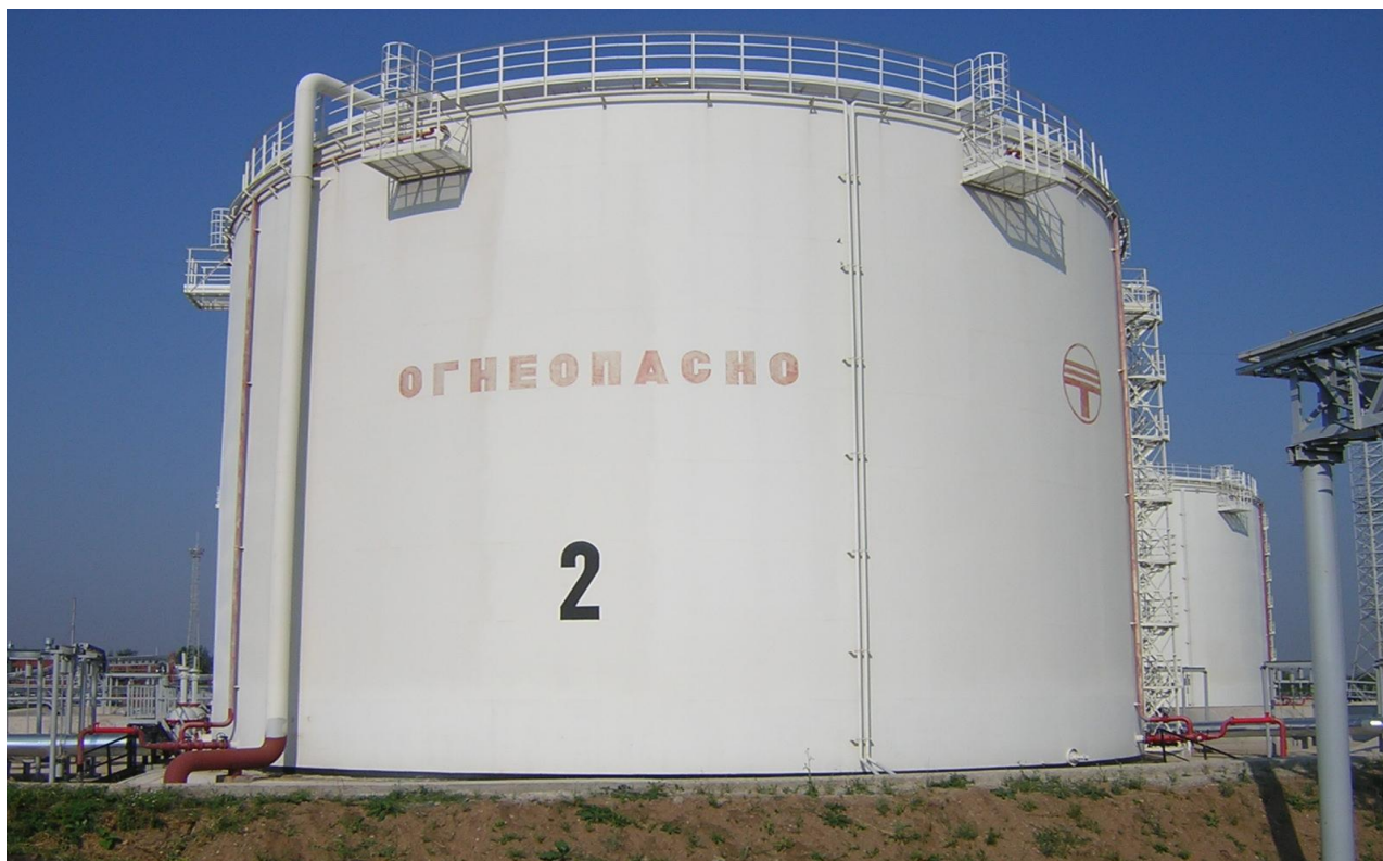
Рисунок 6 - Общий вид резервуара вертикального стального цилиндрического РВС-10000
