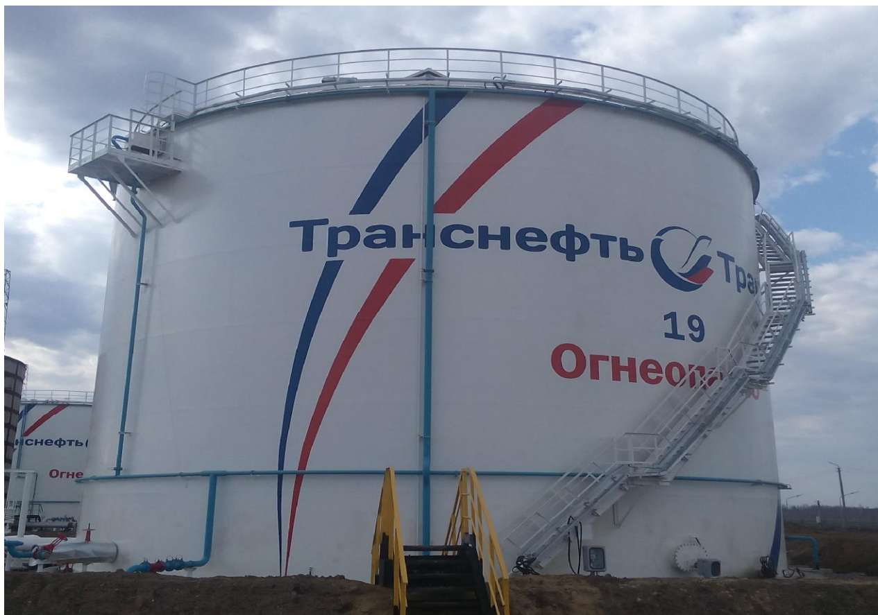
Рисунок 4 - Общий вид резервуара вертикального стального цилиндрического РВС-5000
