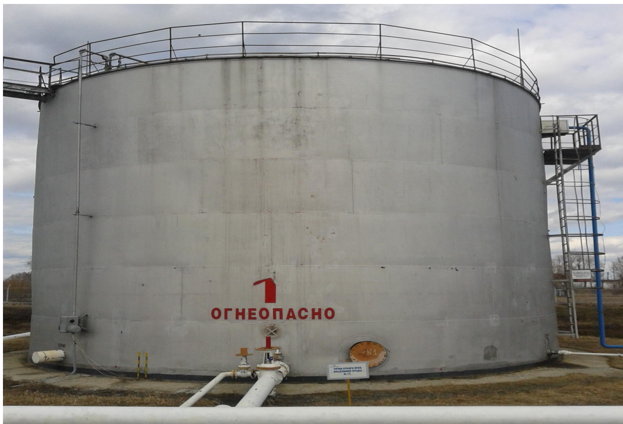
Рисунок 2 - Общий вид резервуара вертикального стального цилиндрического РВС-1000
