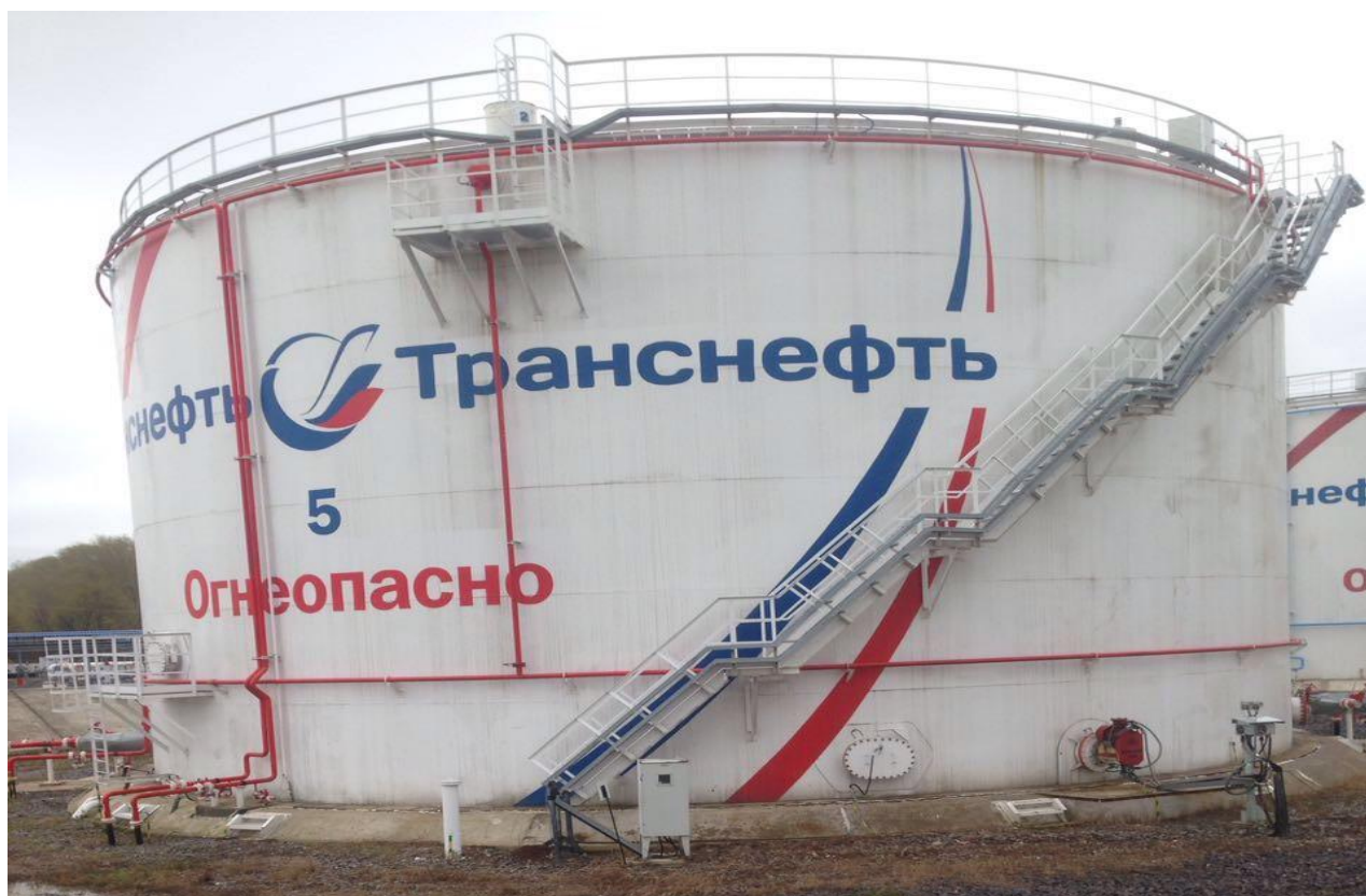
Рисунок 5 - Общий вид резервуара вертикального стального цилиндрического РВСП-5000
