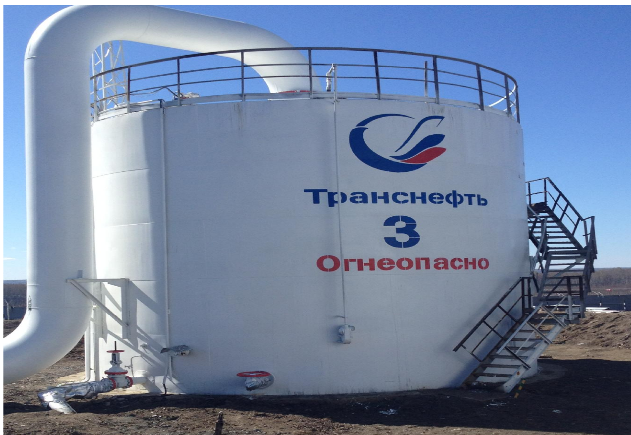
Рисунок 1 - Общий вид резервуара вертикального стального цилиндрического РВС-400
