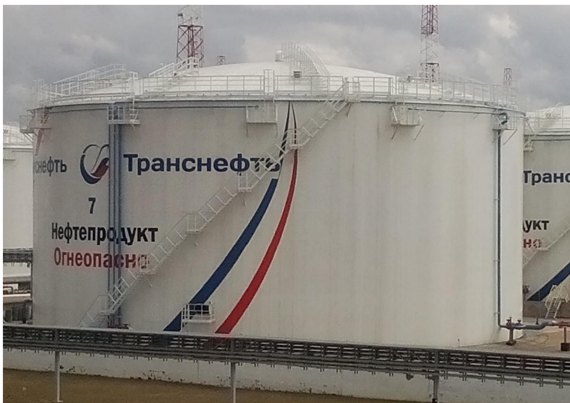
Рисунок 2 - Общий вид резервуара вертикального стального цилиндрического РВСП-20000
