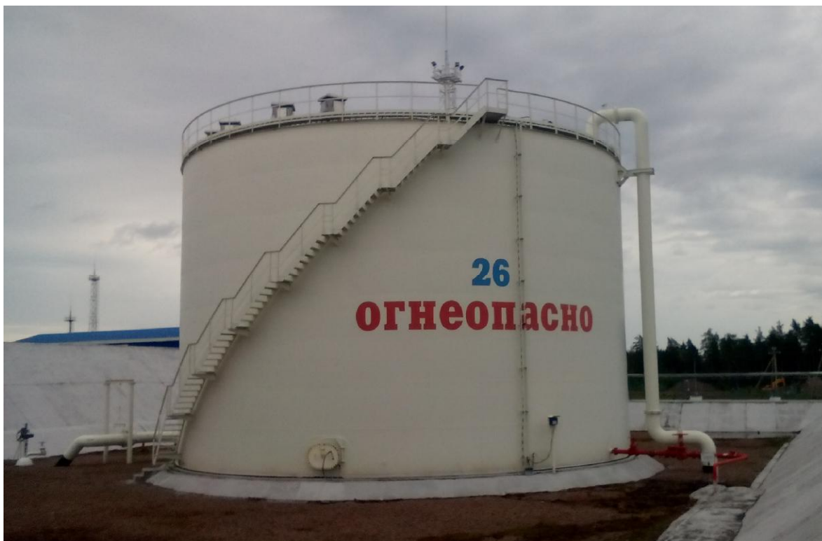
Рисунок 1 - Общий вид резервуара вертикального стального цилиндрического РВС-3000
