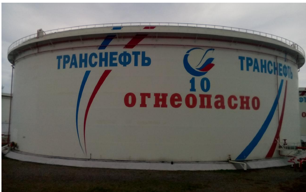
Рисунок 3 - Общий вид резервуара вертикального стального цилиндрического РВСПК-50000
