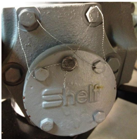
Рисунок 4 - Пломбировка измерителя объема типа Shelf
