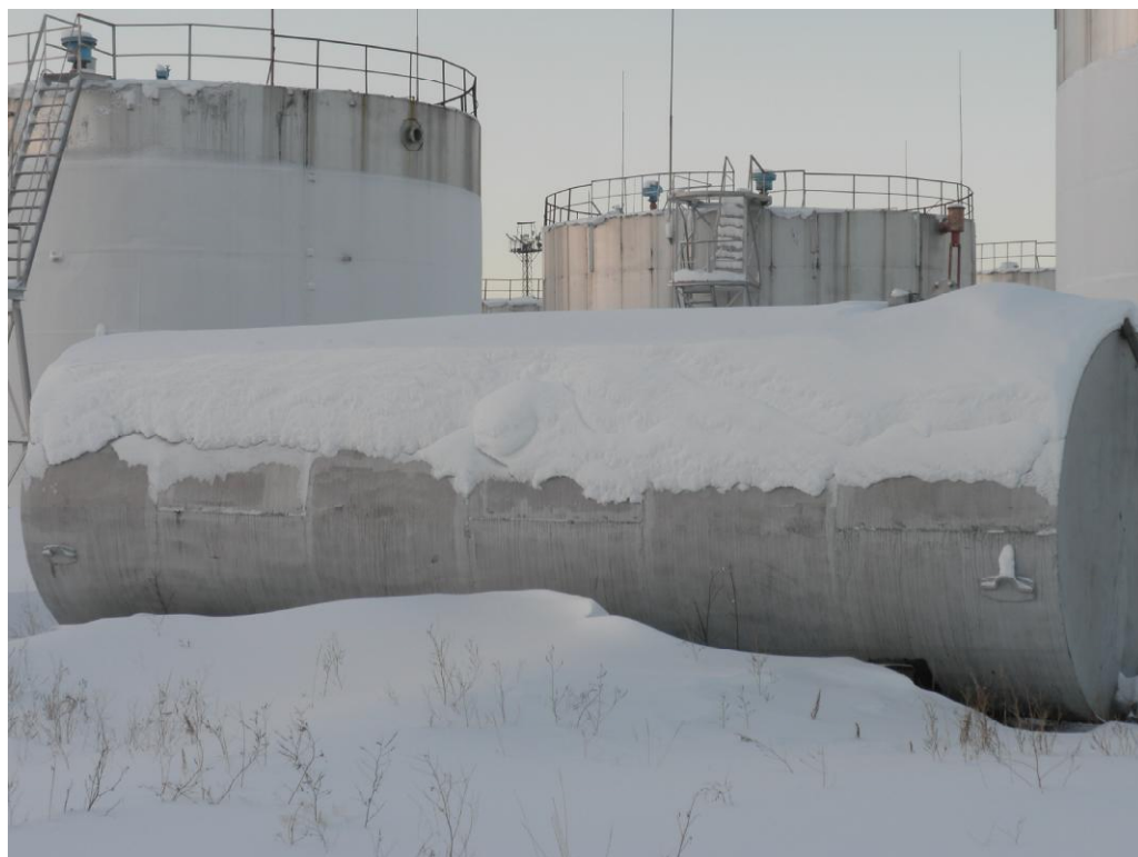
Рисунок 1 - Общий вид резервуара РГС-50
