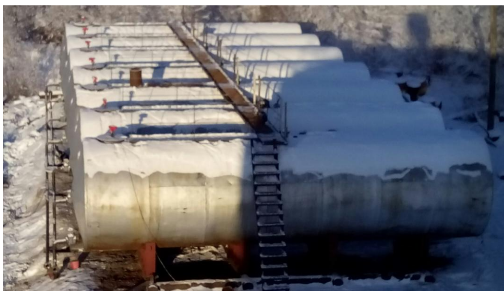
Рисунок 2 - Общий вид резервуара РГС-60
