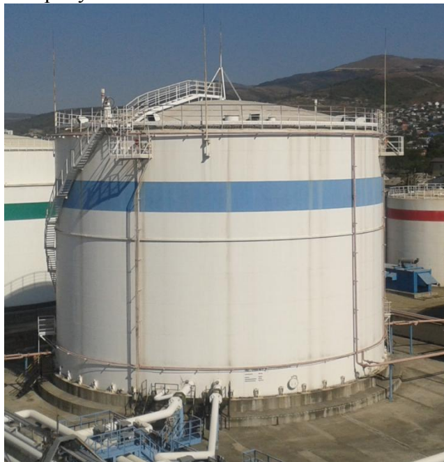
Рисунок 1 – Общий вид резервуара РВСП-12000
