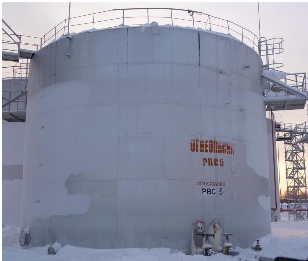
Рисунок 1 - Общий вид резервуара РВС-1000
