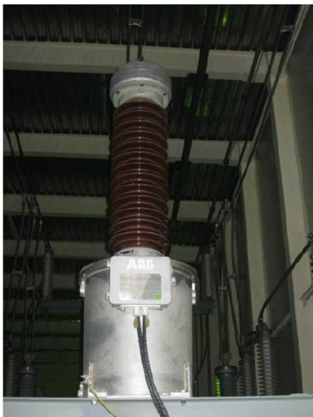
Рисунок 1 - Общий вид трансформаторов напряжения
