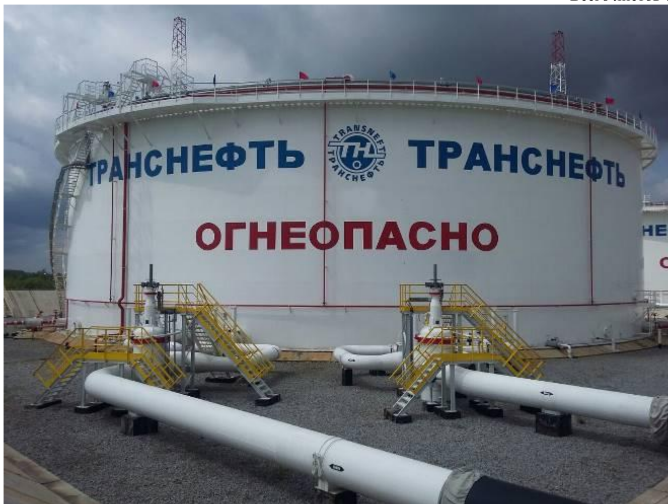
Рисунок 4 – Общий вид резервуара вертикального стального цилиндрического РВСПК-50000
