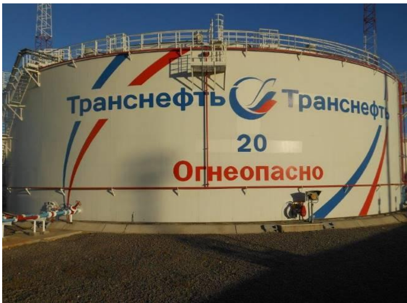
Рисунок 3 – Общий вид резервуара вертикального стального цилиндрического РВСП-20000
