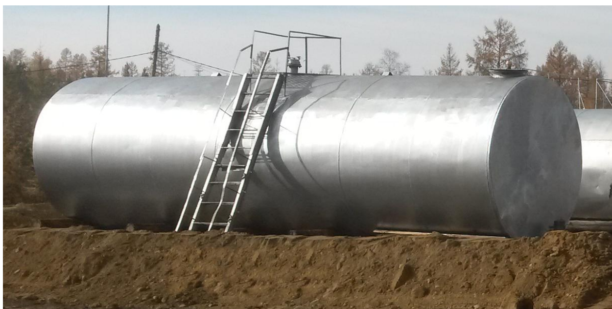
Рисунок 4 - Общий вид резервуаров РГС-70
