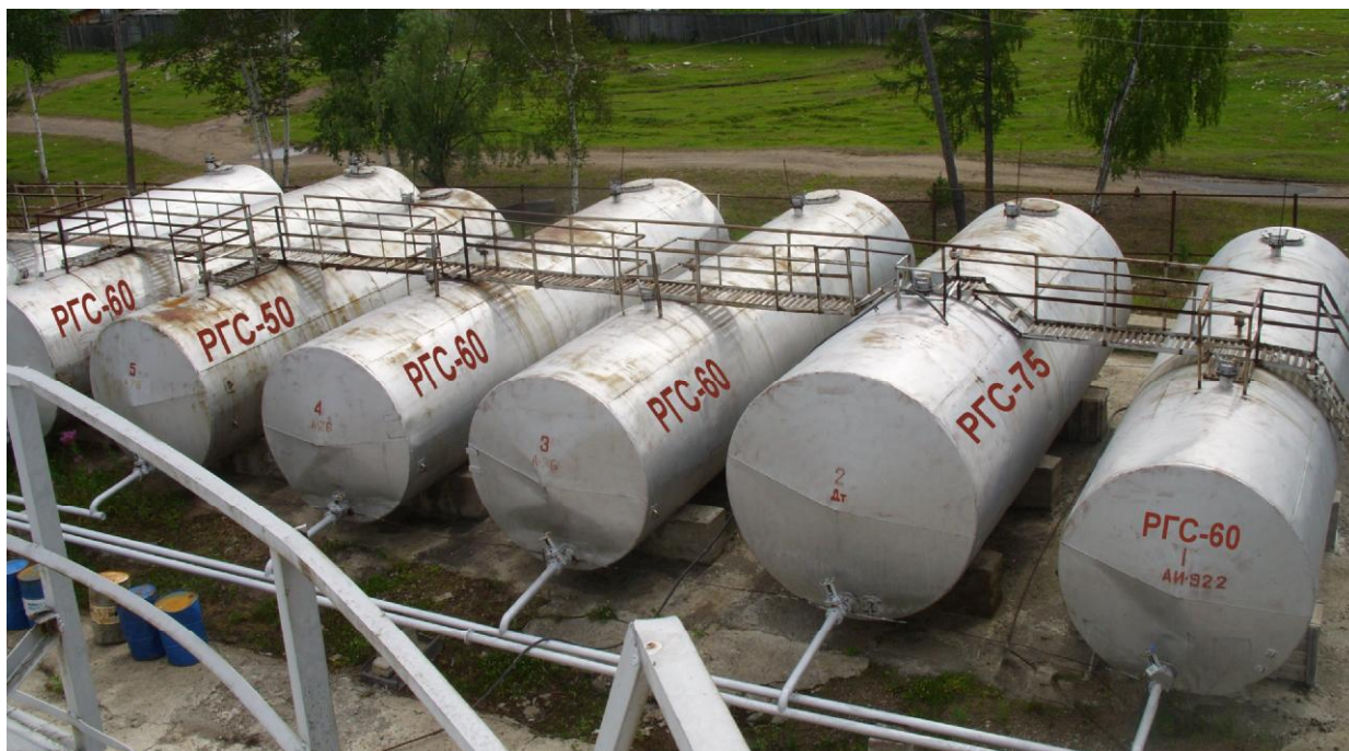
Рисунок 3 - Общий вид резервуаров РГС-50, РГС60, РГС-75
