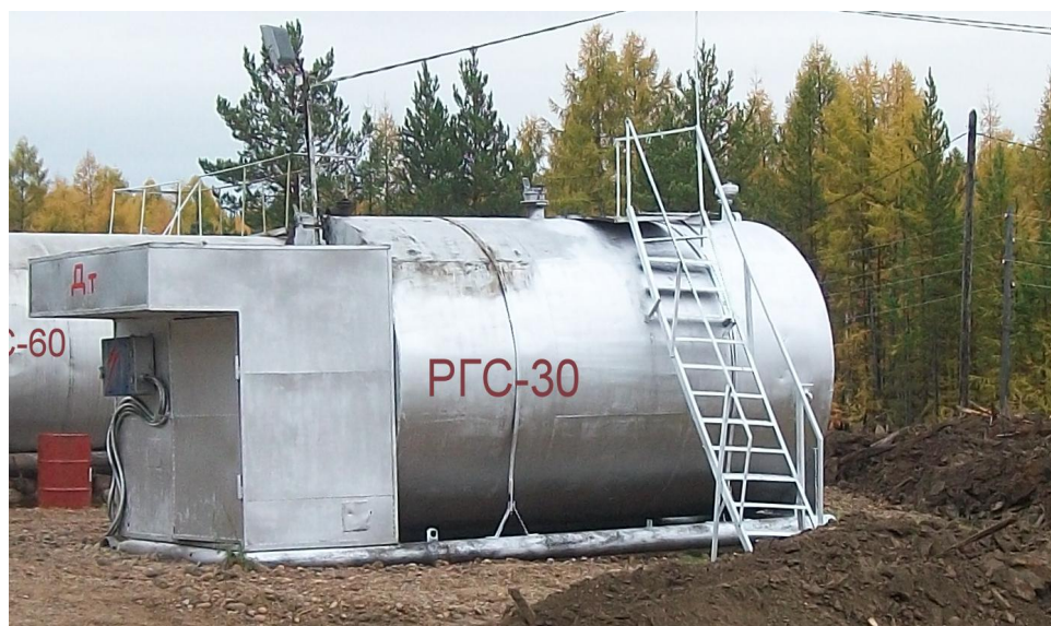
Рисунок 2 - Общий вид резервуара РГС-30
