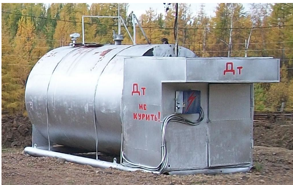
Рисунок 1 - Общий вид резервуара РГС-25
