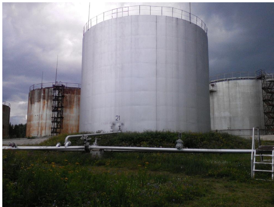
Рисунок 6 - Общий вид резервуара РВС-2000
