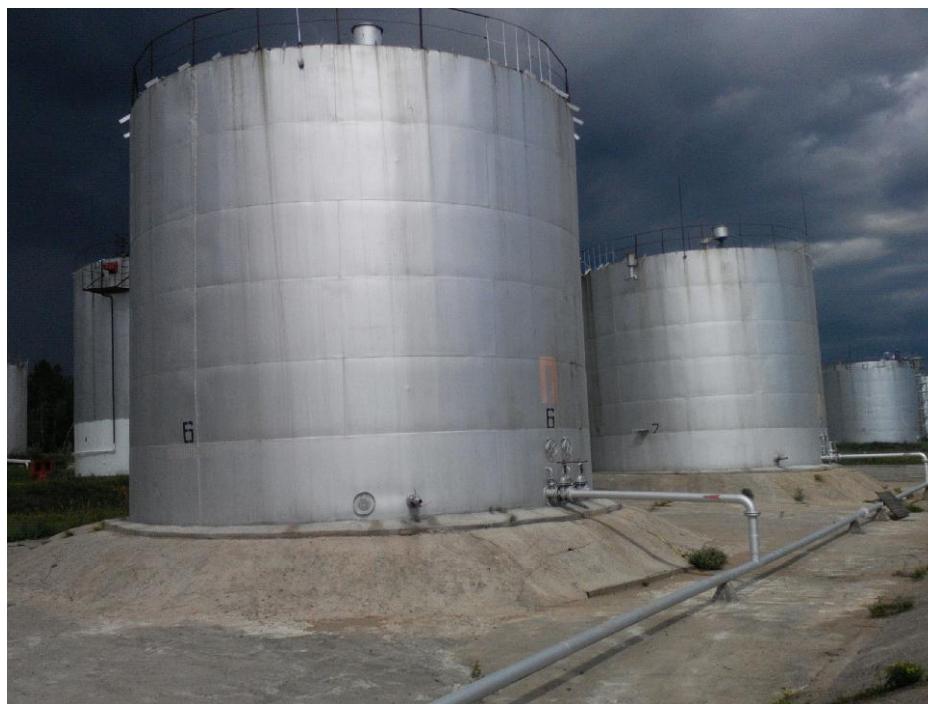
Рисунок 4 - Общий вид резервуара РВС-700
