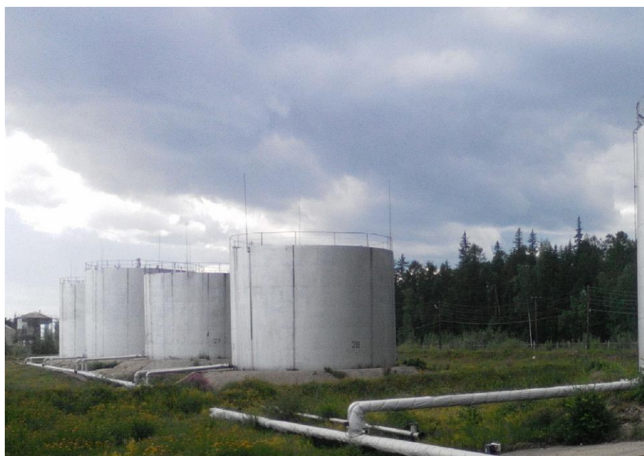
Рисунок 5 - Общий вид резервуара РВС-1000
