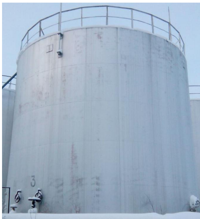
Рисунок 1 - Общий вид резервуара РВС-300
