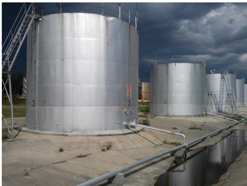
Рисунок 2 - Общий вид резервуара РВС-400
