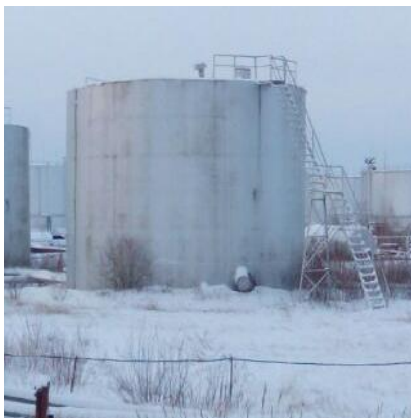
Рисунок 3 - Общий вид резервуара РВС-600
