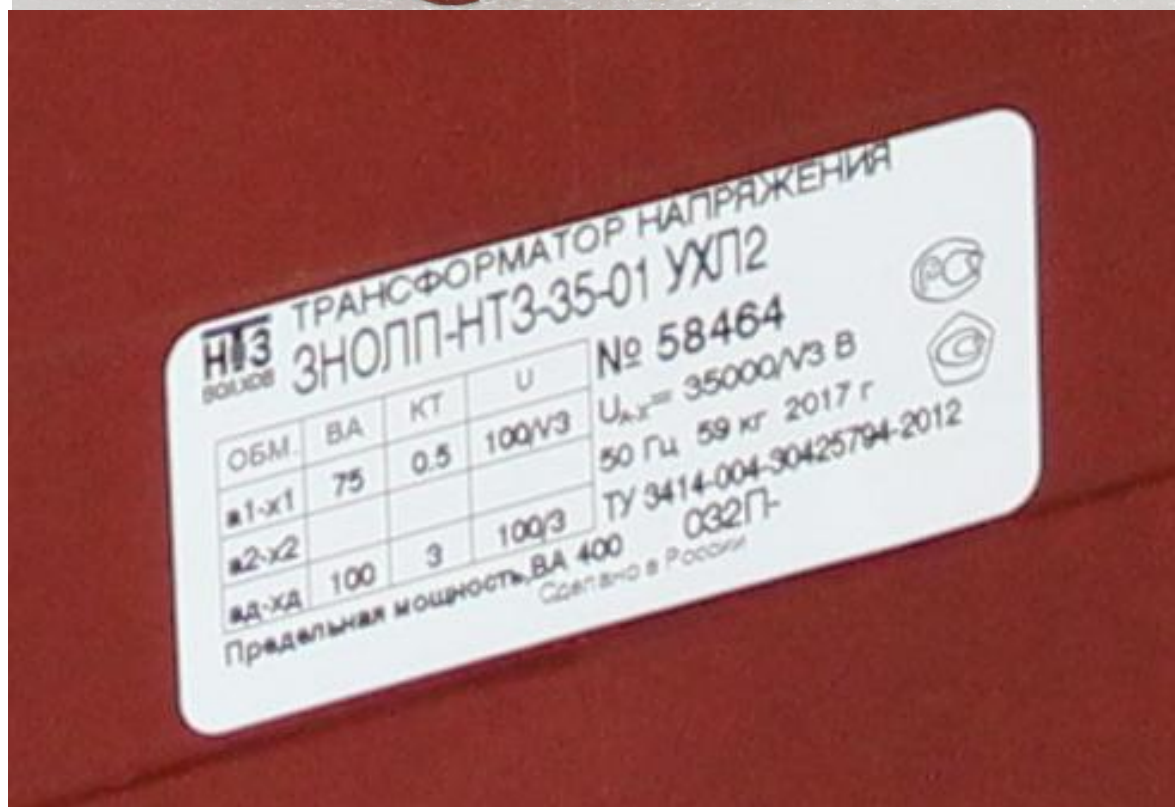
Рисунок 4 - Общий вид трансформаторов напряжения ЗНОЛП-НТЗ-35
