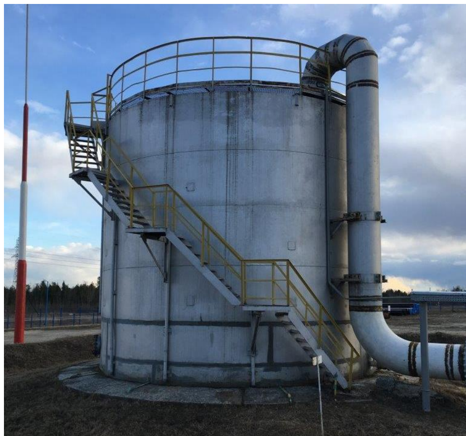
Рисунок 1 - Общий вид резервуара вертикального стального цилиндрического РВС-400
