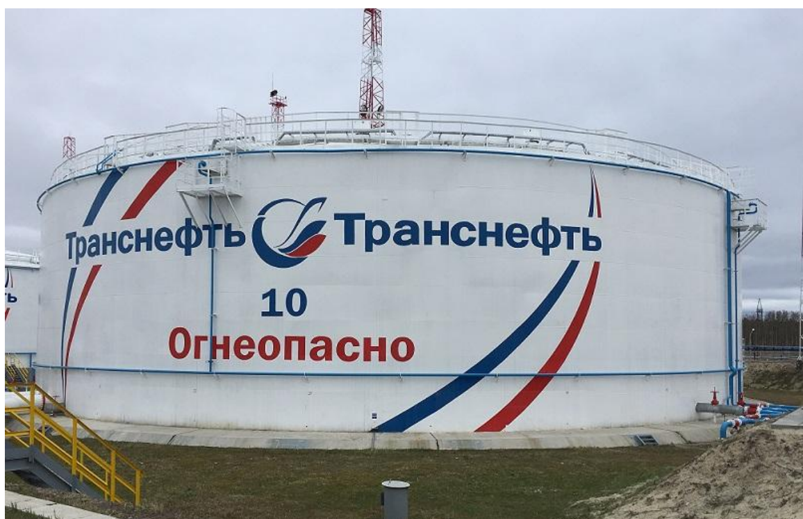
Рисунок 2 - Общий вид резервуара вертикального стального цилиндрического РВСП-20000
