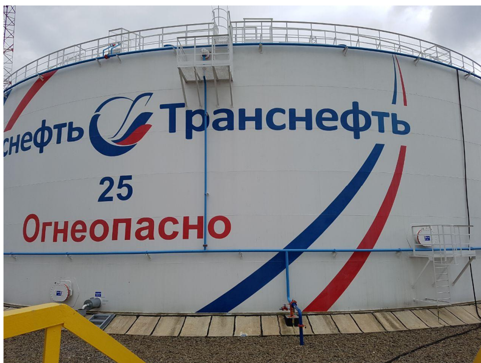
Рисунок 1 - Общий вид резервуара вертикального стального цилиндрического РВСП-20000
