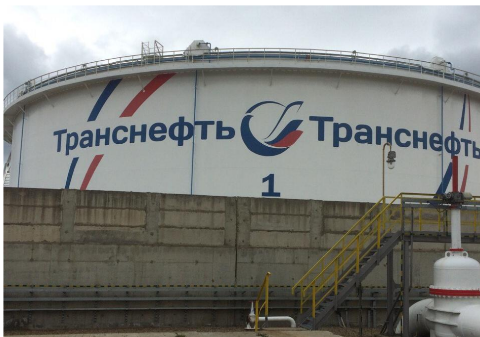
Рисунок 2 - Общий вид резервуара вертикального стального цилиндрического РВСПК-50000
