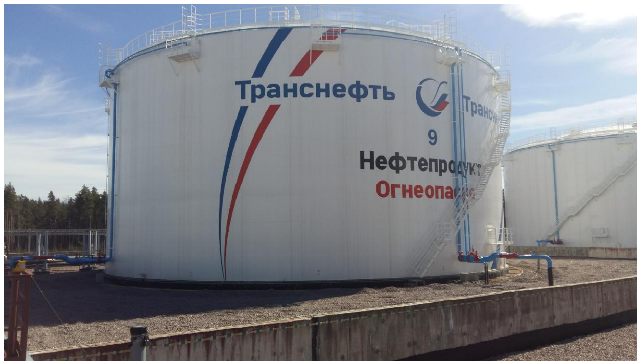
Рисунок 1 – Общий вид резервуара вертикального стального цилиндрического РВСП-20000
