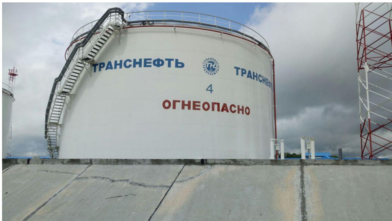
Рисунок 1 – Общий вид резервуара вертикального стального цилиндрического РВС-5000
