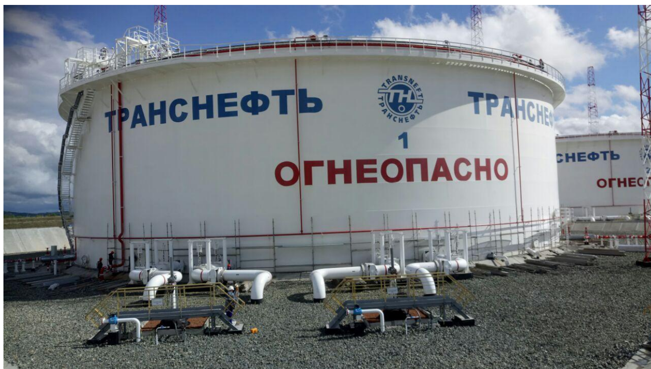
Рисунок 2 – Общий вид резервуара вертикального стального цилиндрического RVSPK-50000
