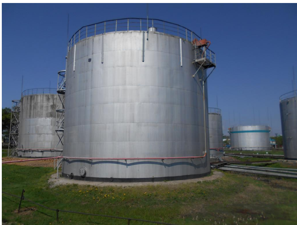
Рисунок 3 - Общий вид резервуара РВС – 2000 № 36
