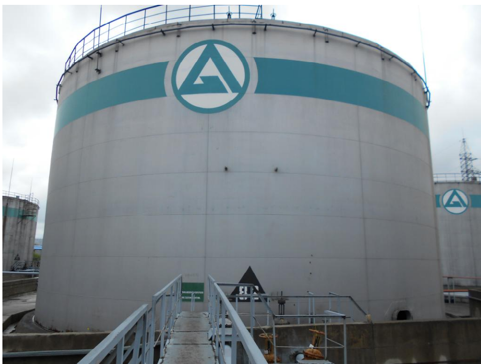
Рисунок 7 - Общий вид резервуара РВС – 5000 № 82
