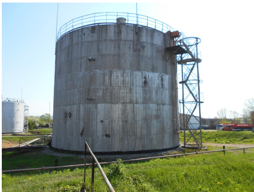
Рисунок 5 - Общий вид резервуара РВС – 2000 № 39
