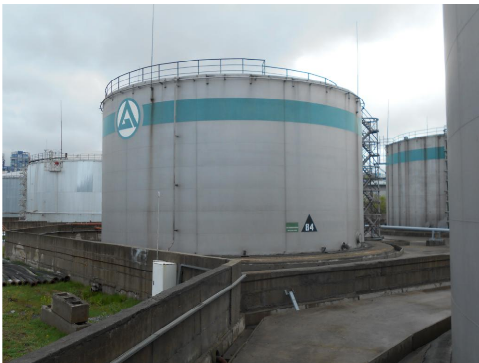
Рисунок 8 - Общий вид резервуара РВС – 5000 № 84
