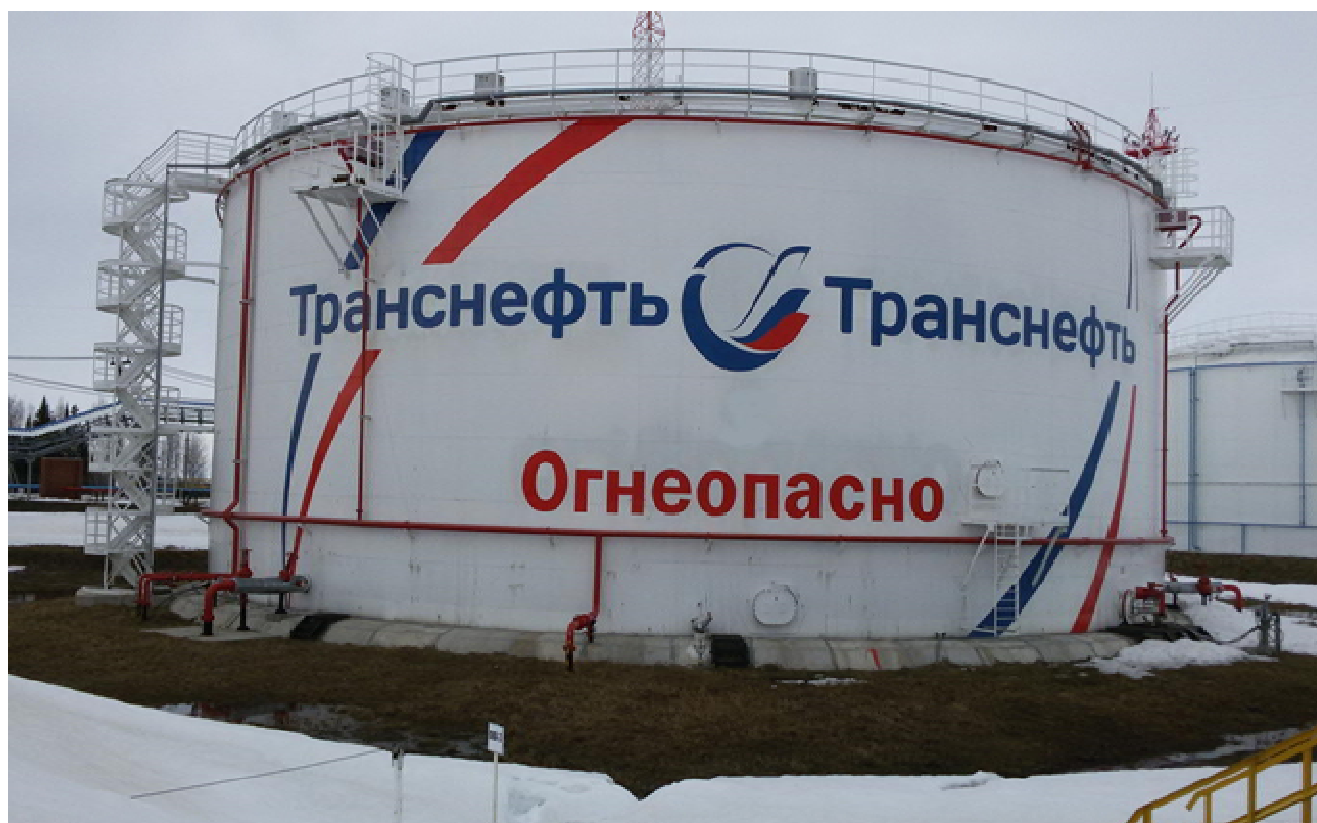
Рисунок 1 - Общий вид резервуара вертикального стального цилиндрического РВС-7500
