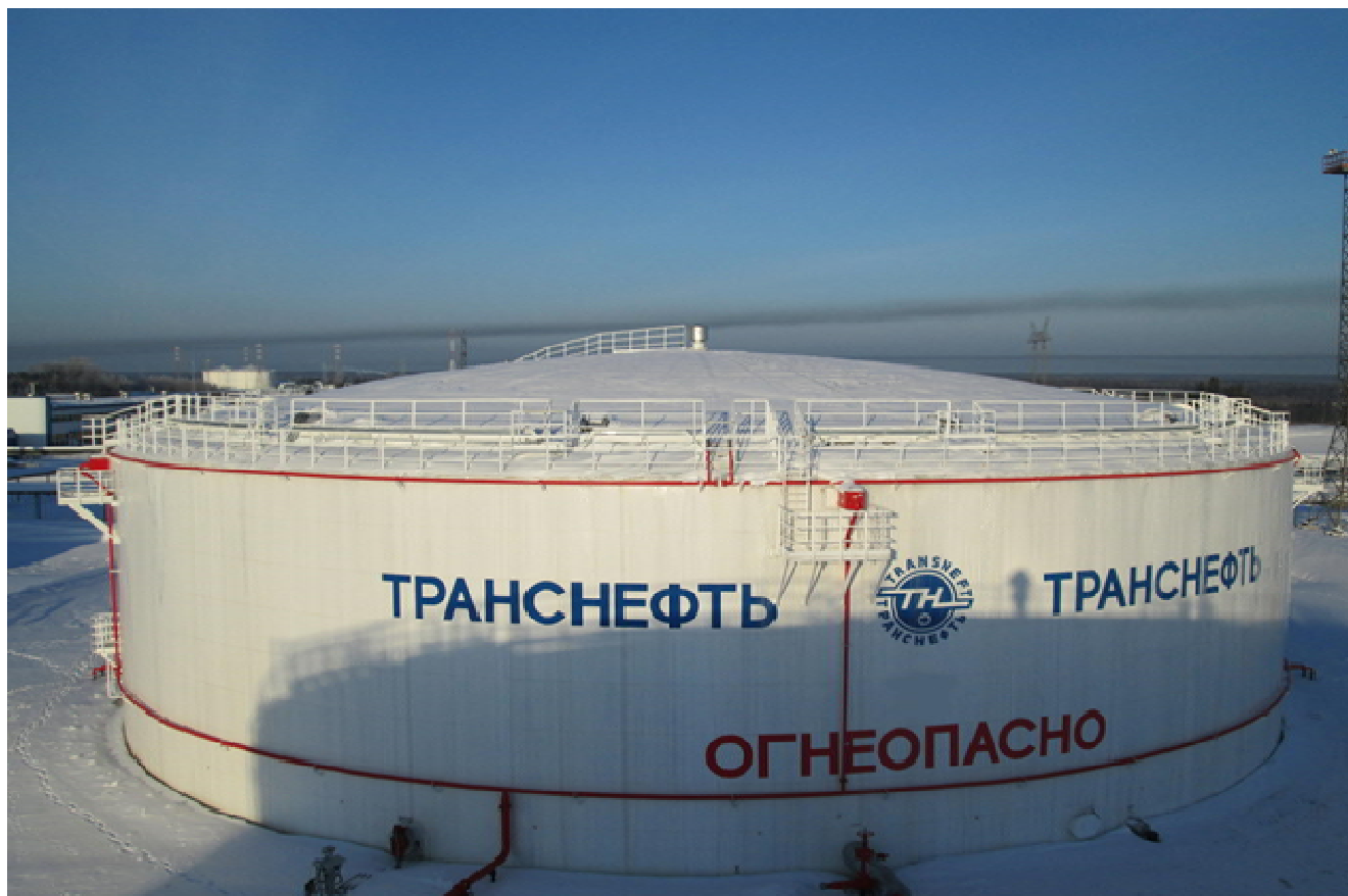
Рисунок 3 - Общий вид резервуара вертикального стального цилиндрического РВСПА-20000
