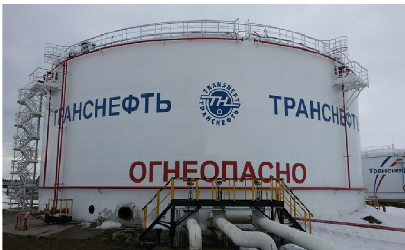
Рисунок 2 - Общий вид резервуара вертикального стального цилиндрического РВСП-7500
