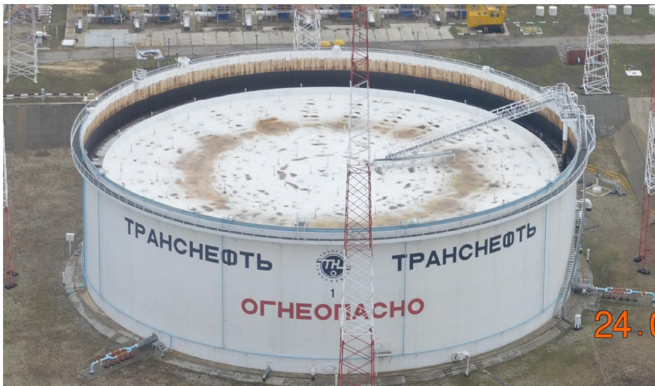
Рисунок 1 - Общий вид резервуара вертикального стального цилиндрического РВСПК-50000
