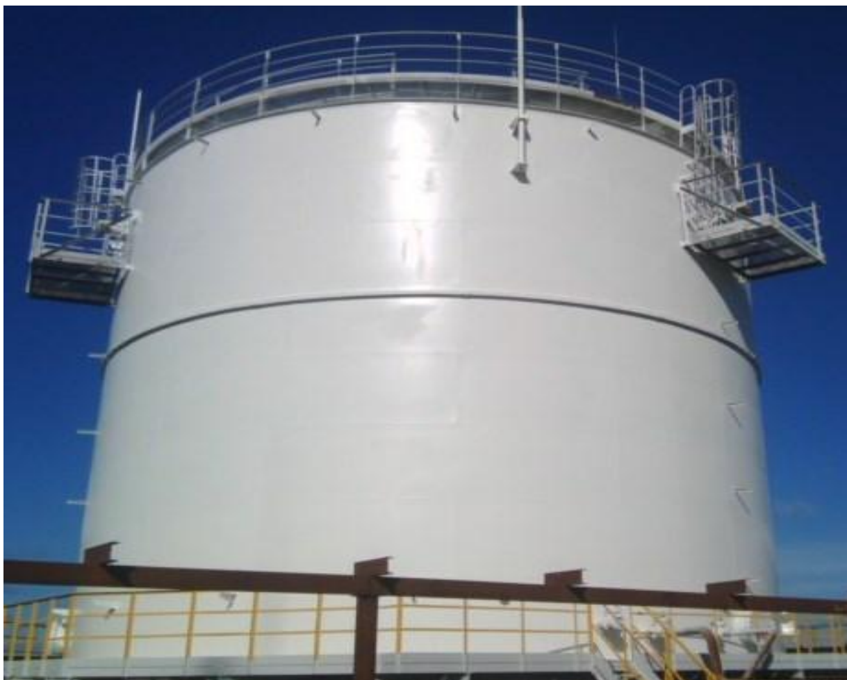
Рисунок 2 - Общий вид резервуара стального вертикального цилиндрического РВС-2000
