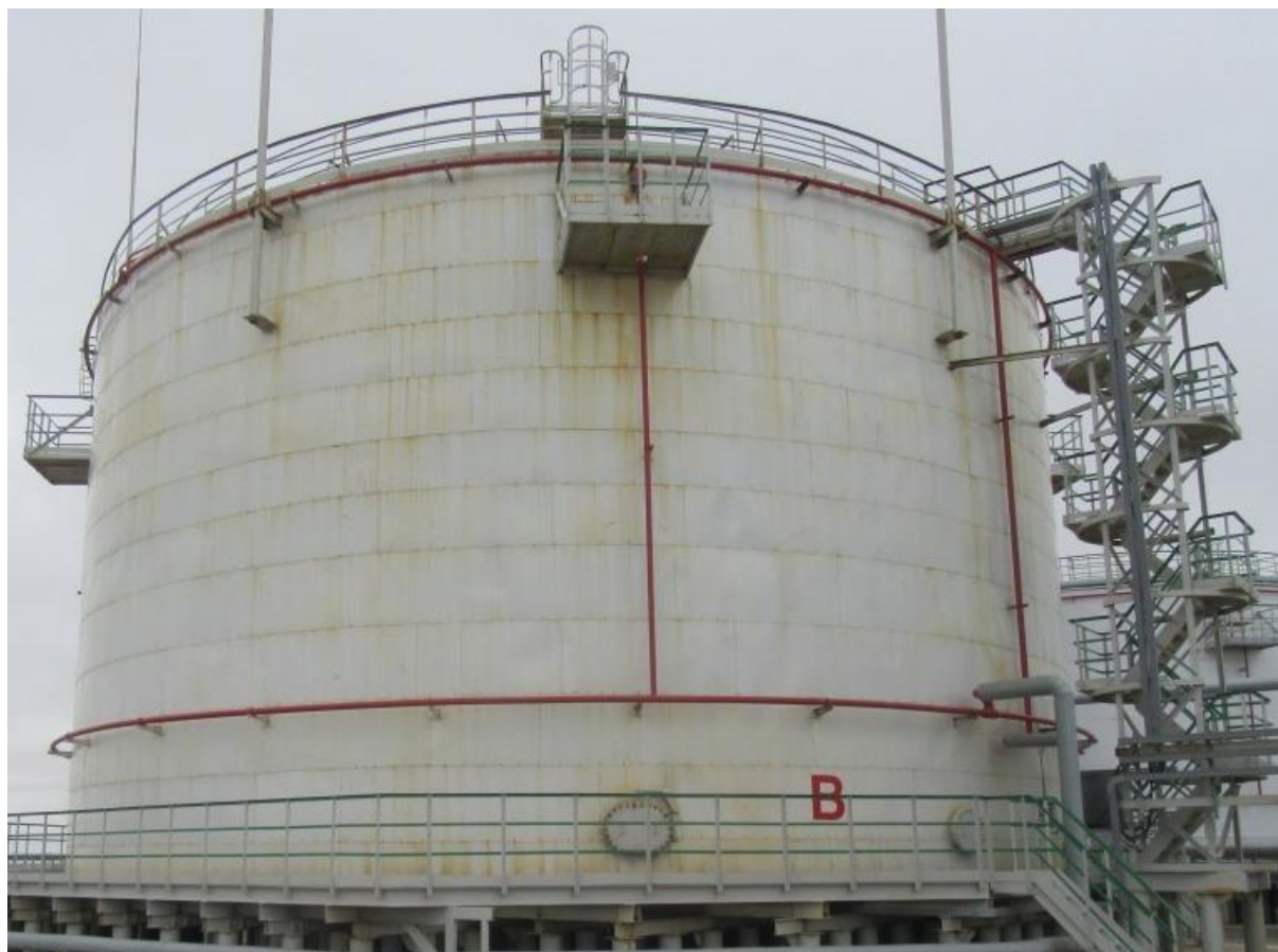
Рисунок 1 - Общий вид резервуара стального вертикального цилиндрического РВС-5000
