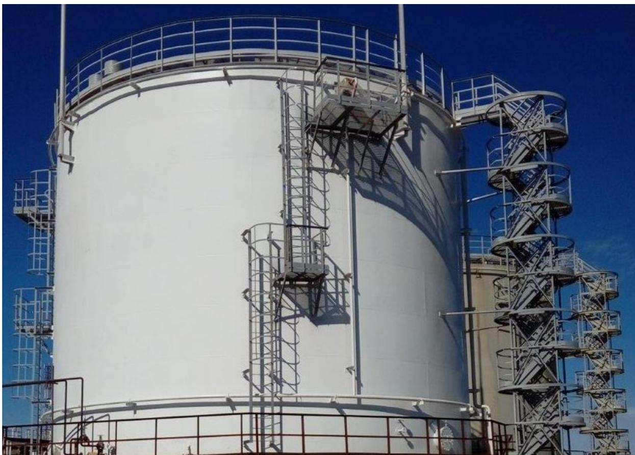
Рисунок 1 - Общий вид резервуара стального вертикального цилиндрического РВС-2000
