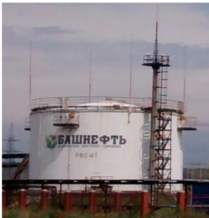
Рисунок 3 - Общий вид резервуаров стальных вертикальных цилиндрических с понтоном РВСП-3000
