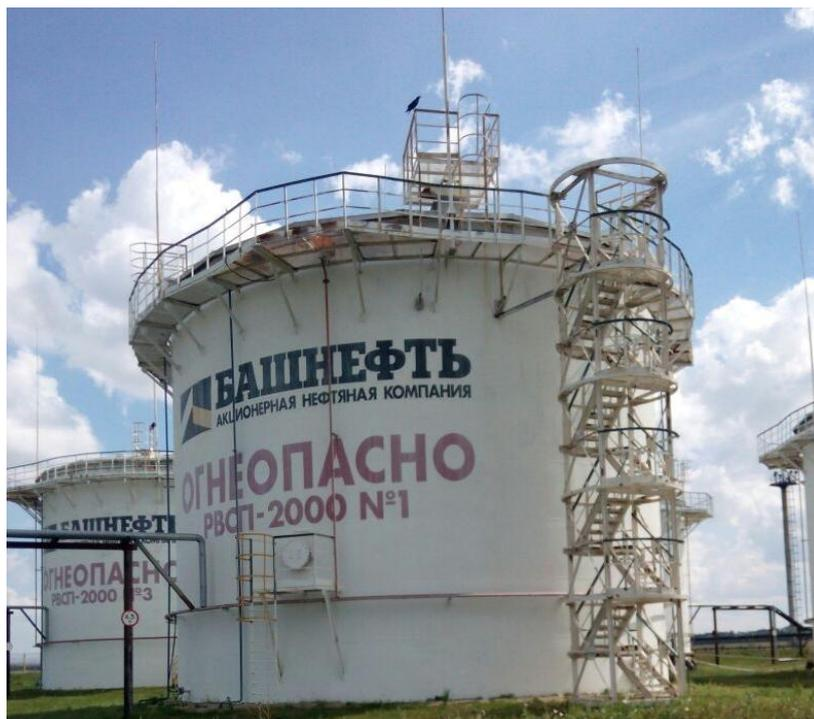
Рисунок 2 - Общий вид резервуаров стальных вертикальных цилиндрических с понтоном РВСП-2000
