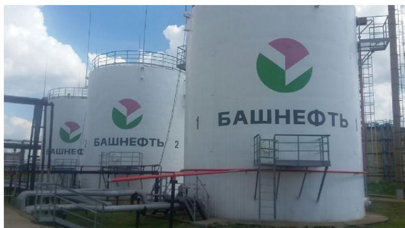
Рисунок 1 - Общий вид резервуаров стальных вертикальных цилиндрических с понтоном РВСП-1000
