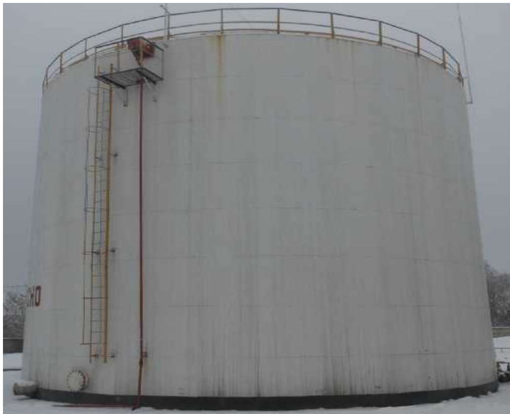
Рисунок 1 - Общий вид резервуара стального вертикального цилиндрического РВС-2000, РВСП-2000
