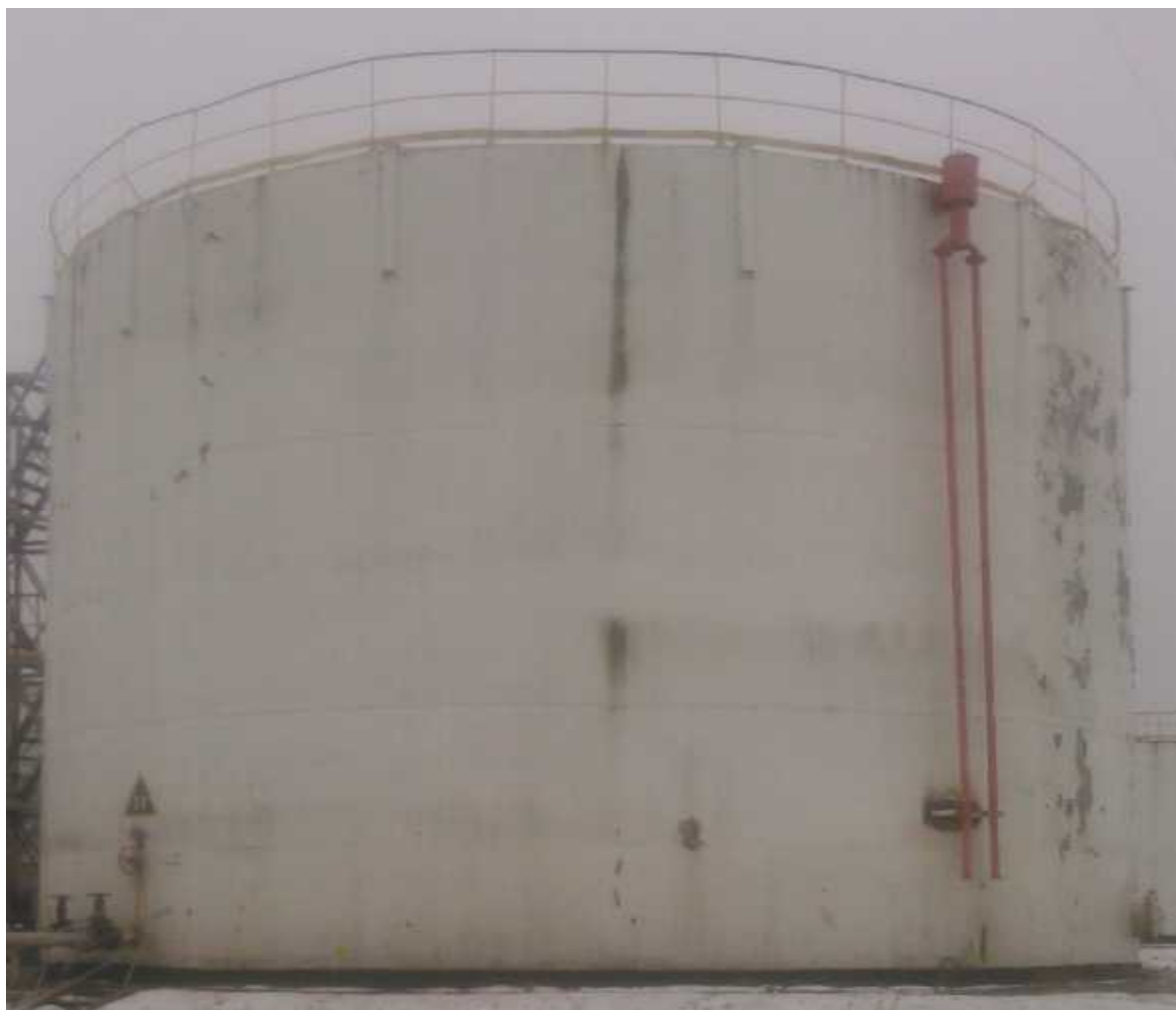
Рисунок 1 - Общий вид резервуара стального вертикального цилиндрического РВС-1000
