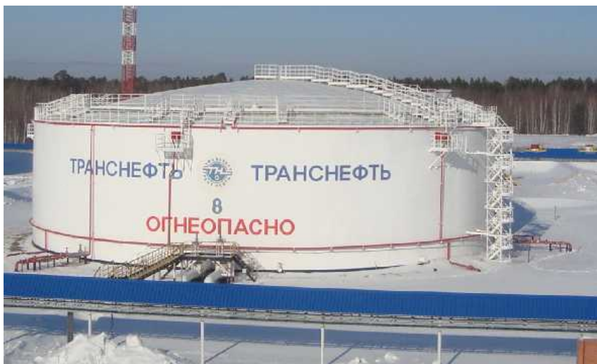
Рисунок 2 - Общий вид резервуара вертикального стального цилиндрического РВСП-20000
