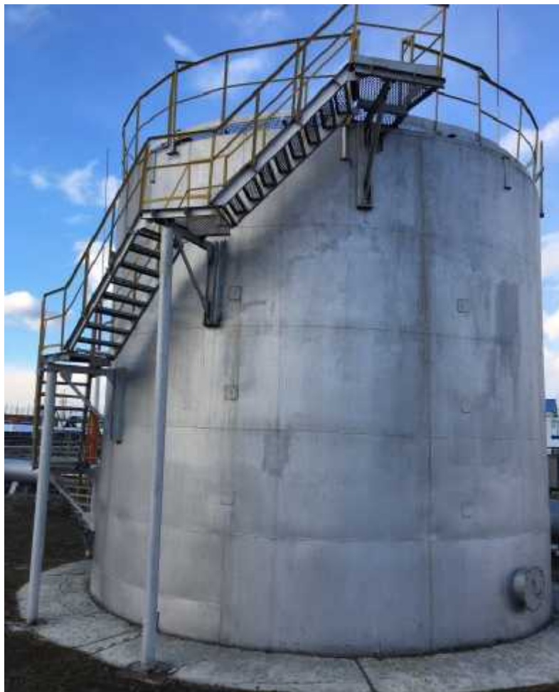
Рисунок 1 - Общий вид резервуара вертикального стального цилиндрического РВС-400
