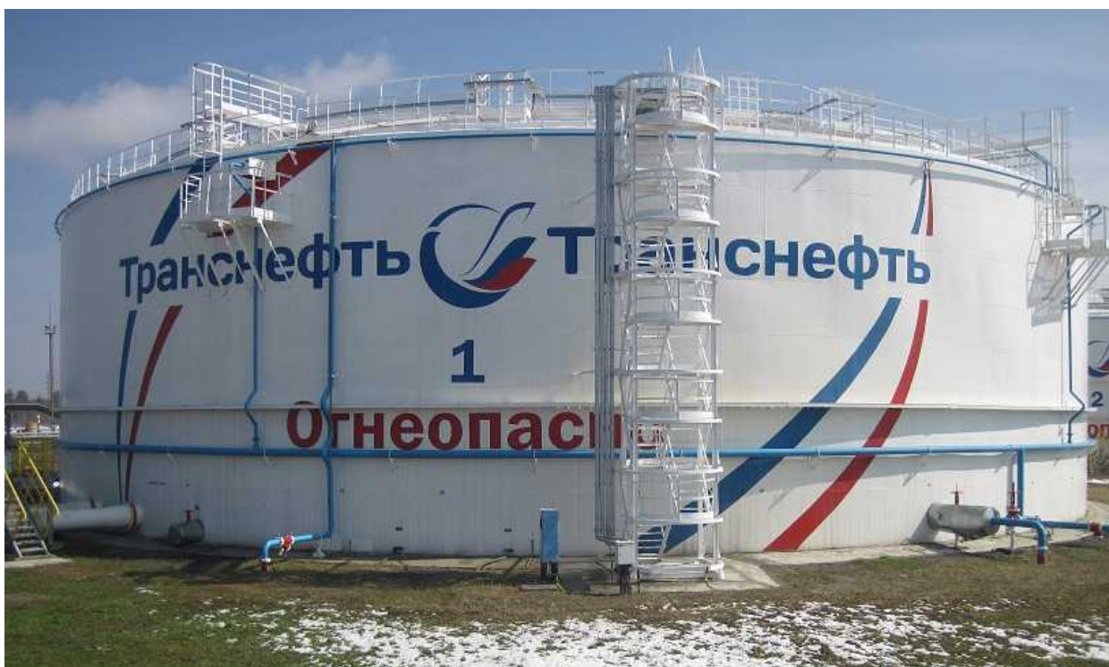
Рисунок 2 - Общий вид резервуара вертикального стального цилиндрического РВС-20000
