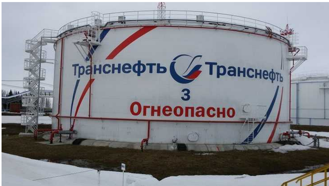
Рисунок 3 - Общий вид резервуара вертикального стального цилиндрического РВСП-10000
