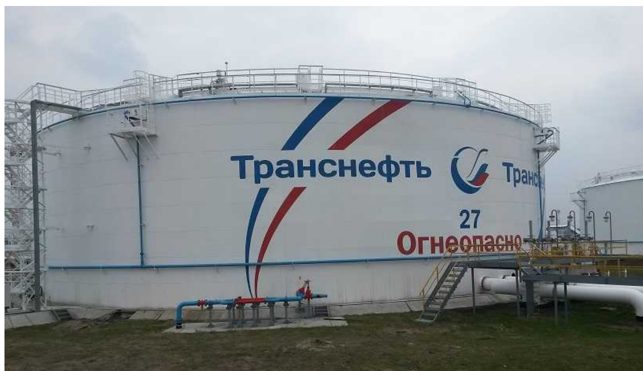
Рисунок 4 - Общий вид резервуара вертикального стального цилиндрического РВСП-20000
