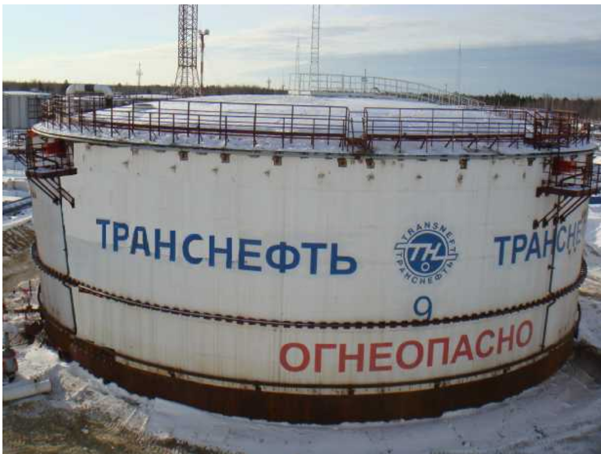
Рисунок 1 - Общий вид резервуара вертикального стального цилиндрического РВС-10000
