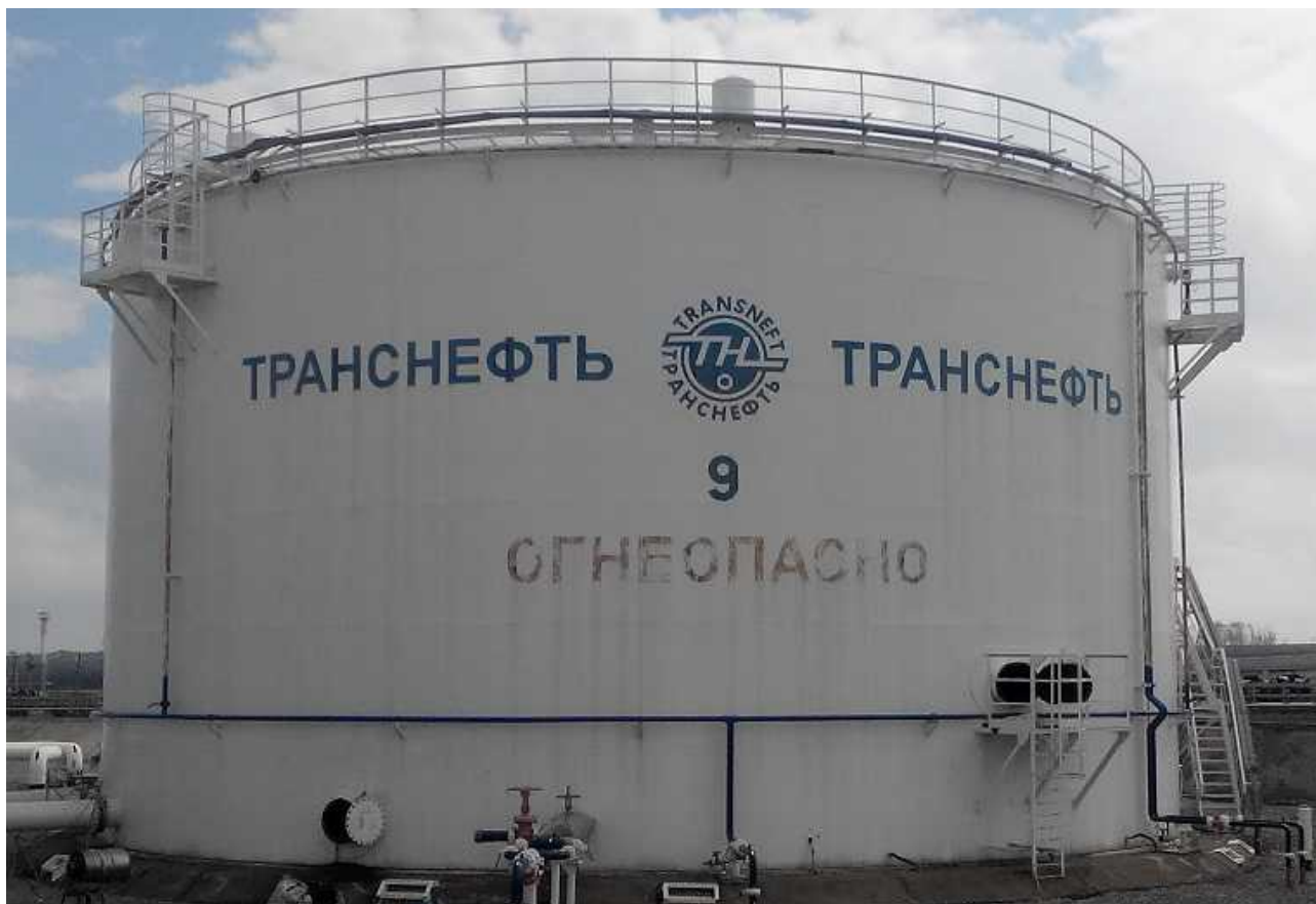
Рисунок 1 - Общий вид резервуара вертикального стального цилиндрического РВСП-5000
