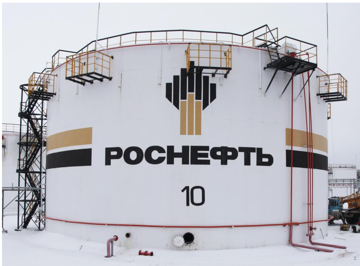
Рисунок 1 - Общий вид резервуара стального вертикального цилиндрического РВС-5000
