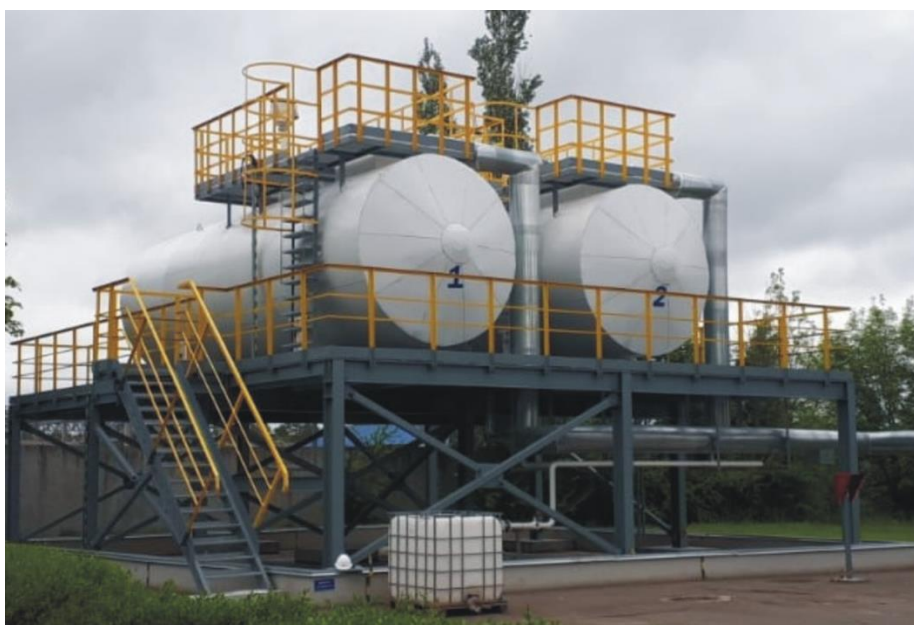
Рисунок 1 – Общий вид резервуаров РГС-50
