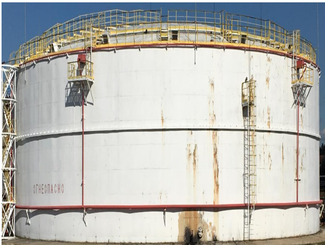
Рисунок 1 - Общий вид резервуара стального вертикального цилиндрического РВСП-20000
