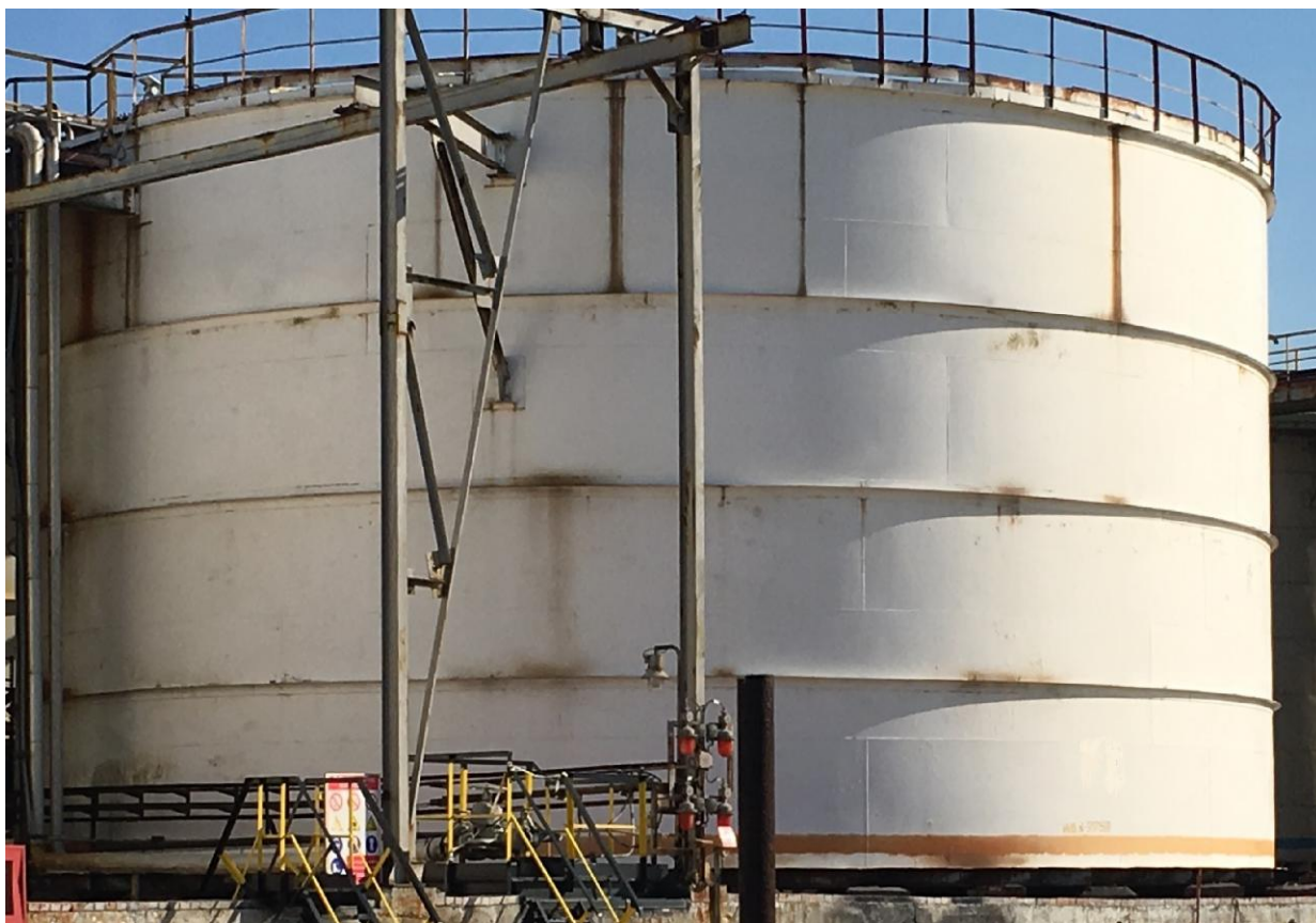
Рисунок 1 - Общий вид резервуара стального вертикального цилиндрического РВС-2000
