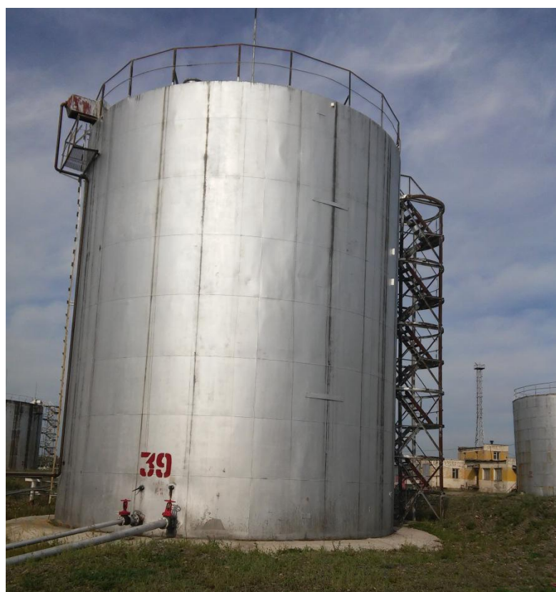
Рисунок 2 - Общий вид резервуара РВС-1000
