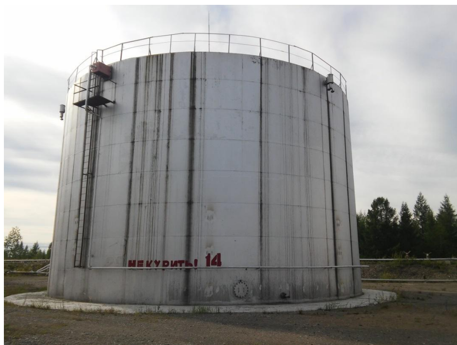
Рисунок 4 - Общий вид резервуара РВС-3000
