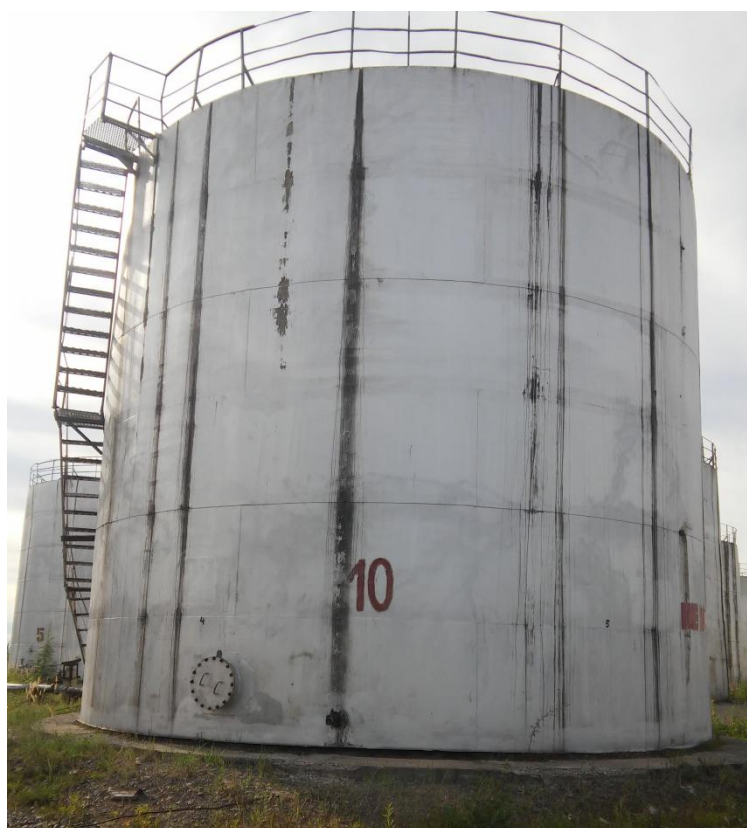
Рисунок 1 - Общий вид резервуара РВС-700
