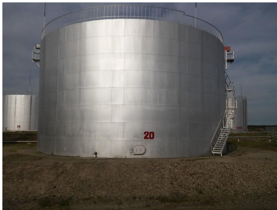
Рисунок 5 - Общий вид резервуара РВС-5000
