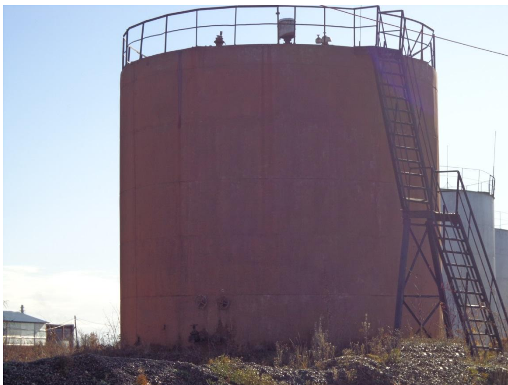
Рисунок 1 - Общий вид резервуара РВС-400
