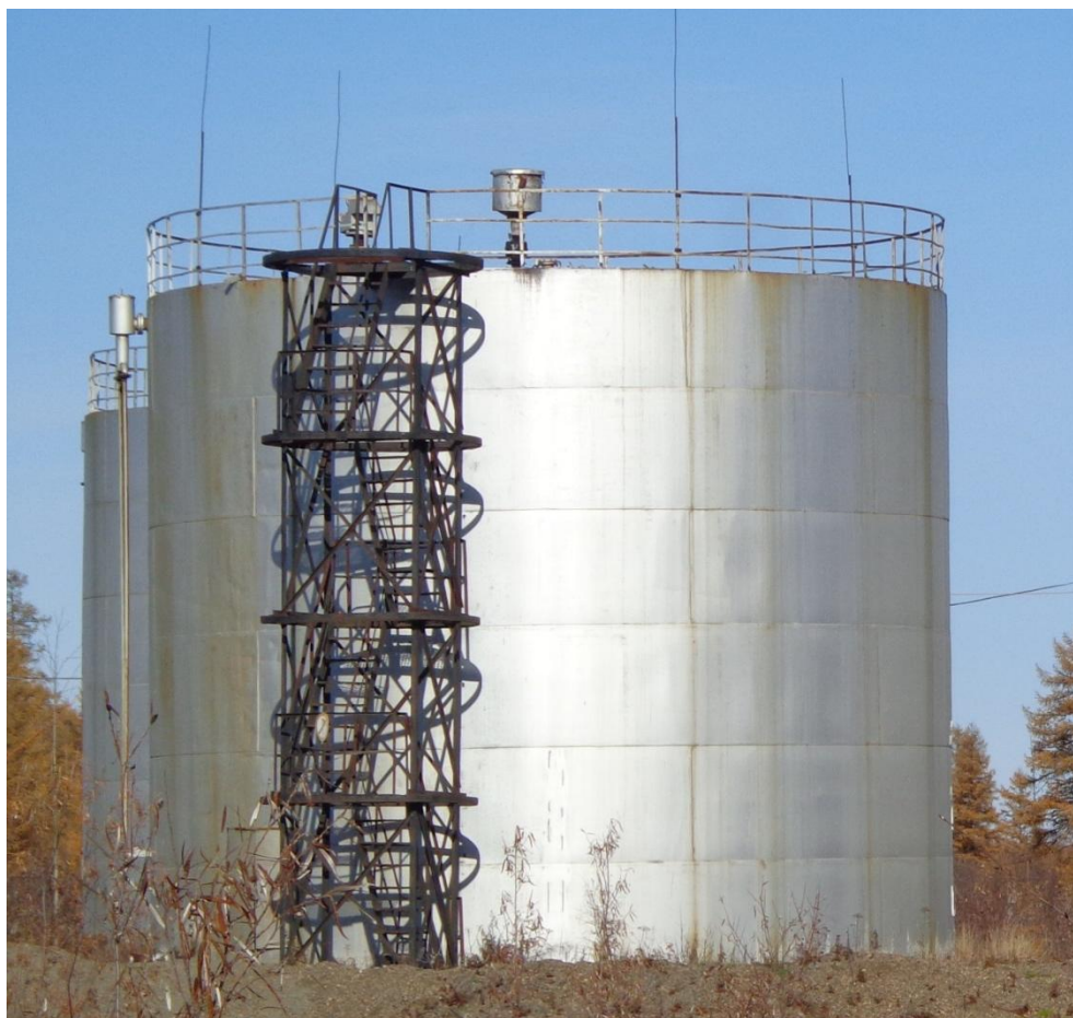
Рисунок 2 - Общий вид резервуара РВС-700
