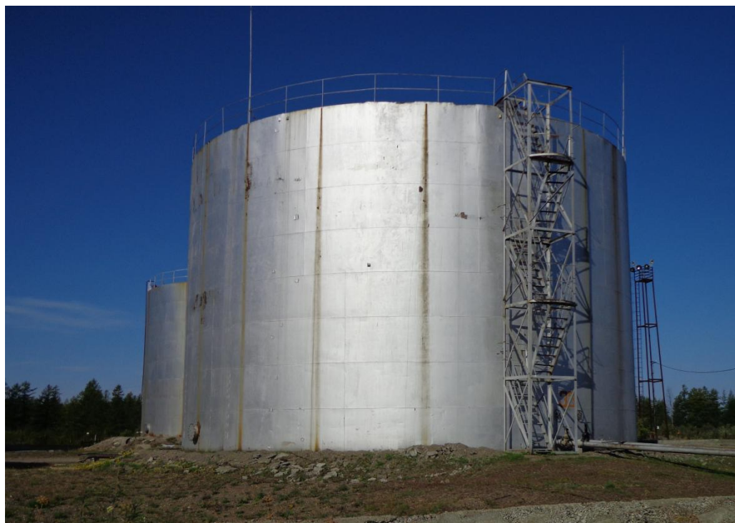
Рисунок 4 - Общий вид резервуара РВС-3000
