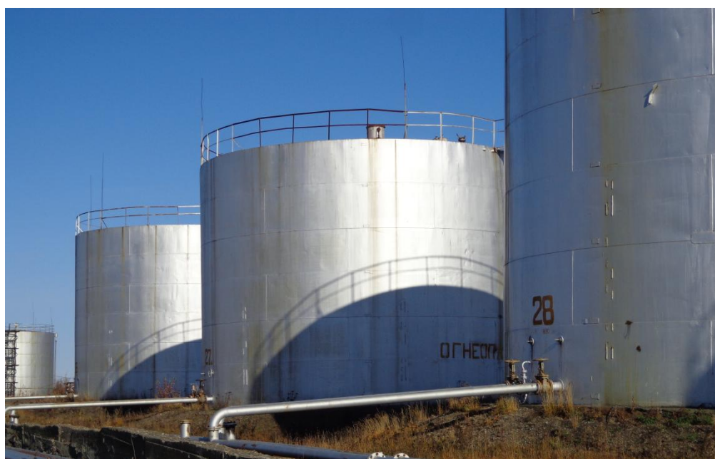
Рисунок 3 - Общий вид резервуара РВС-1000
