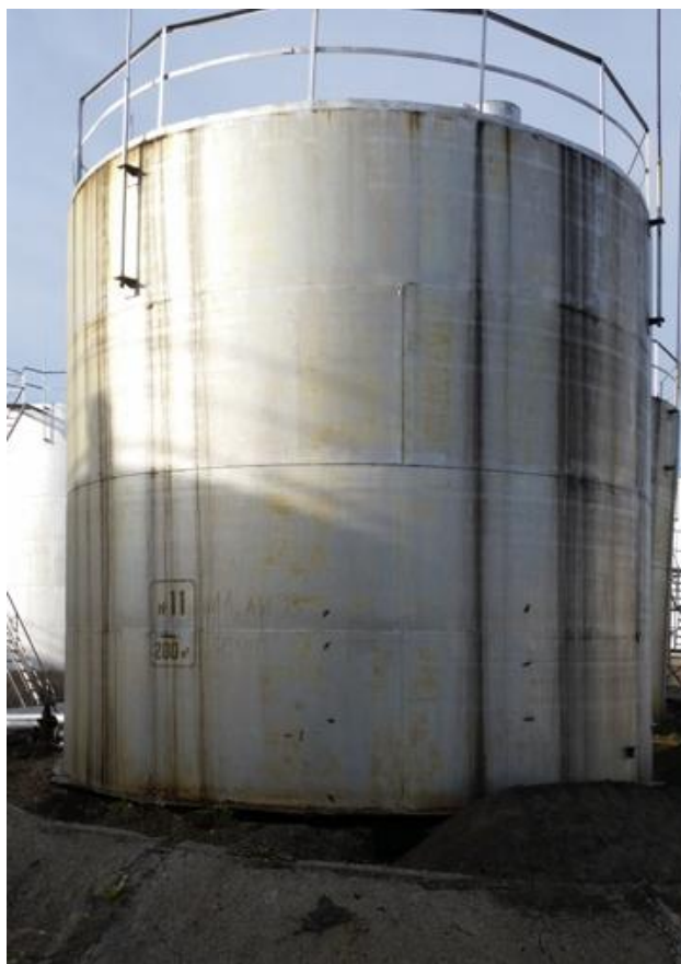
Рисунок 1 - Общий вид резервуара РВС-200
