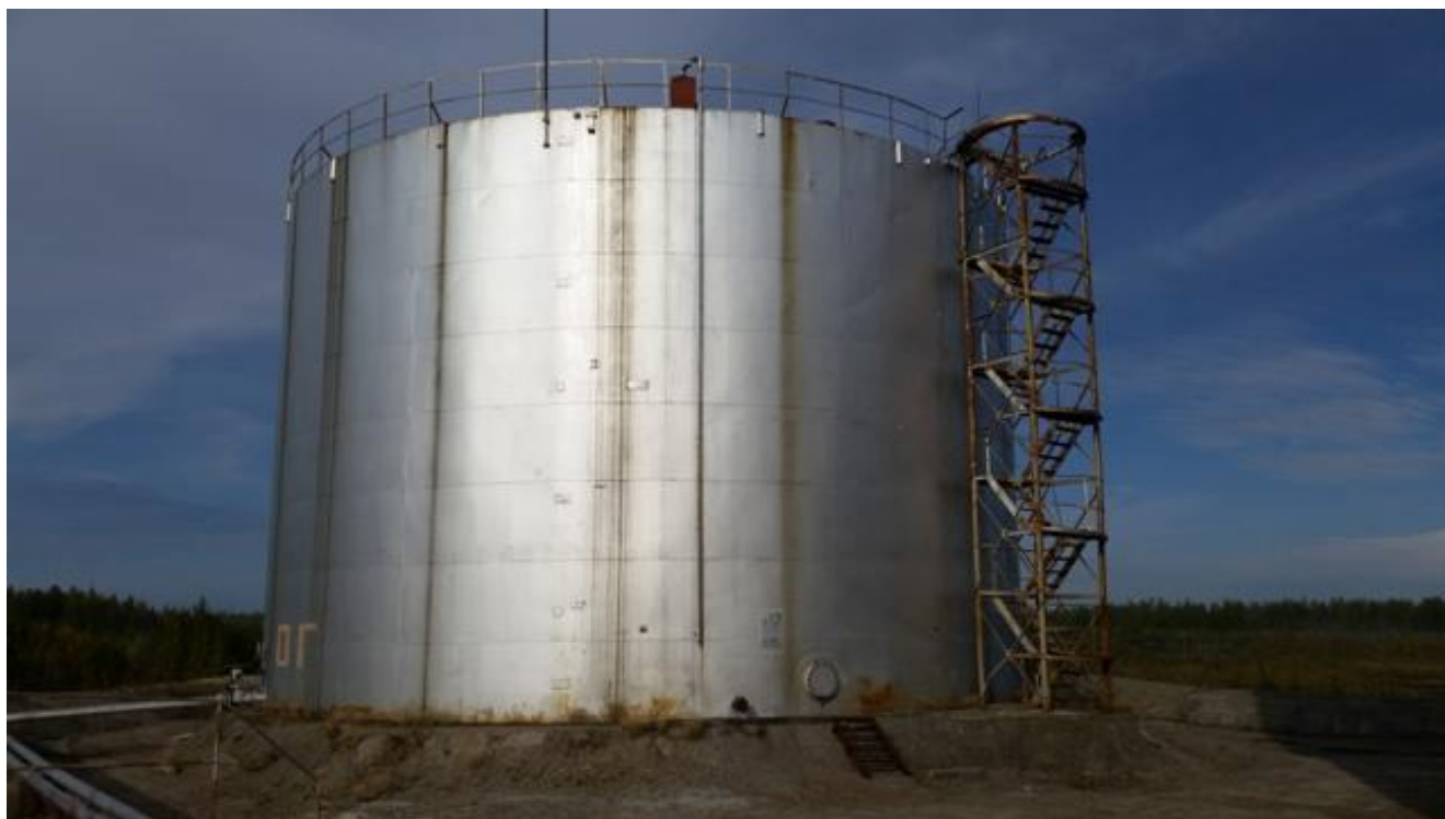
Рисунок 4 - Общий вид резервуара РВС-3000
