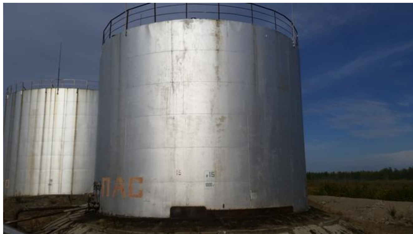
Рисунок 3 - Общий вид резервуара РВС-1000
