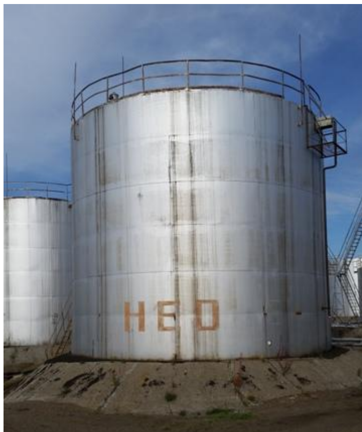
Рисунок 2 - Общий вид резервуара РВС-700
