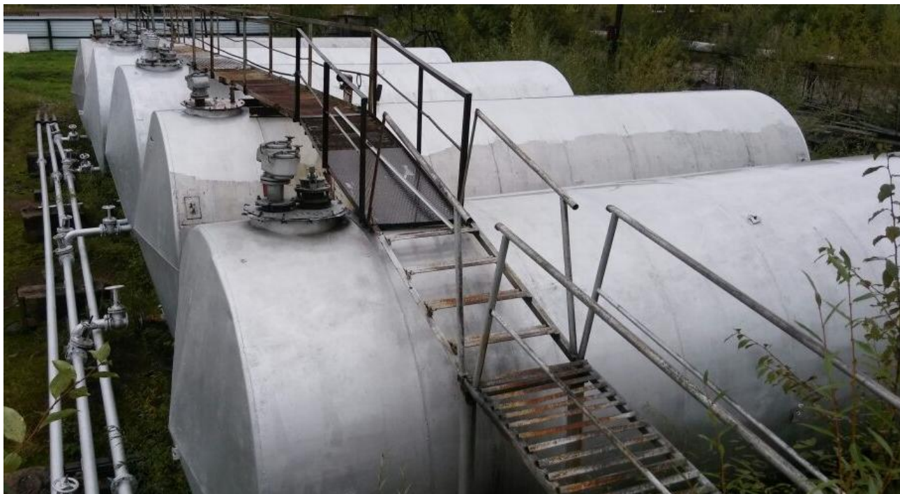
Рисунок 2 - Общий вид резервуара РГС-50
