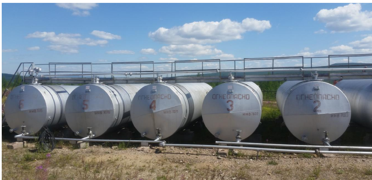
Рисунок 3 - Общий вид резервуара РГС-60
