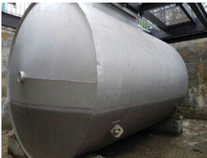
Рисунок 1 - Общий вид резервуара РГС-20
