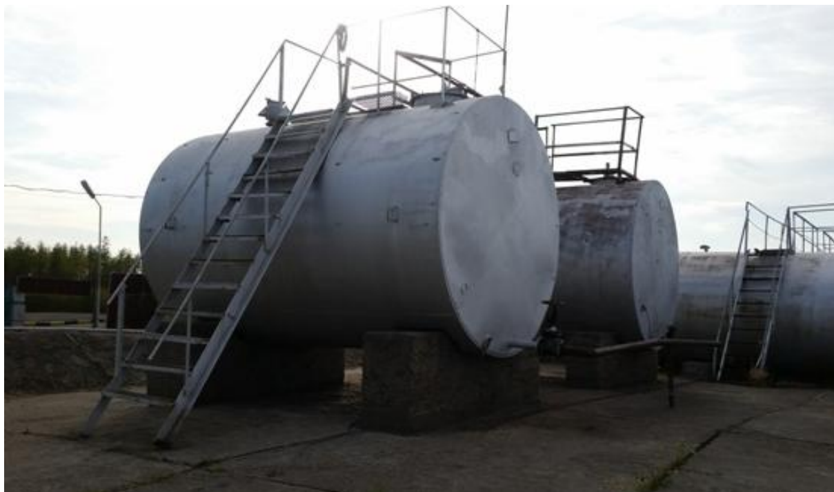
Рисунок 1 - Общий вид резервуара РГС-25
