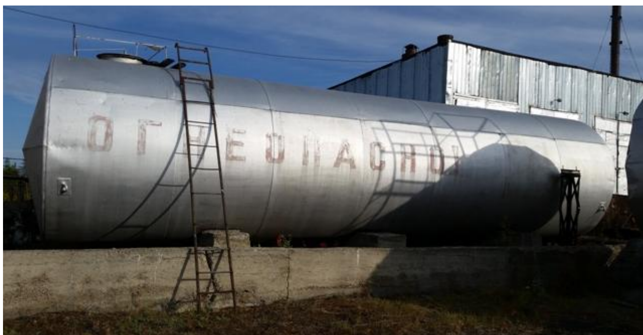
Рисунок 3 - Общий вид резервуара РГС-60
