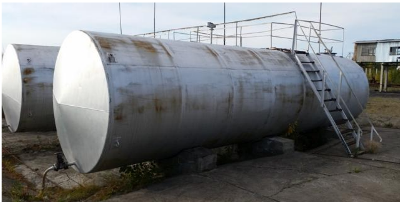
Рисунок 2 - Общий вид резервуара РГС-50
