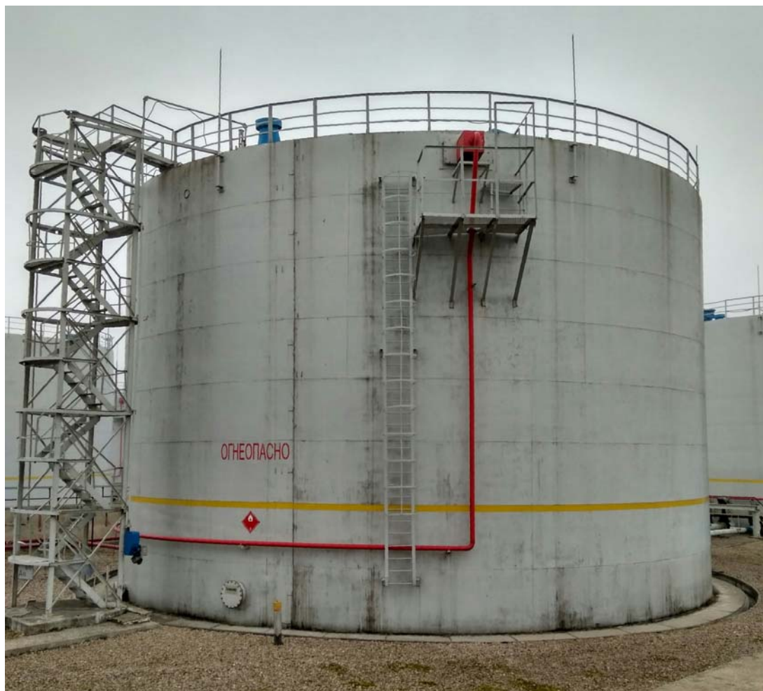
Рисунок 2 - Общий вид резервуара стального вертикального цилиндрического РВС-3000
