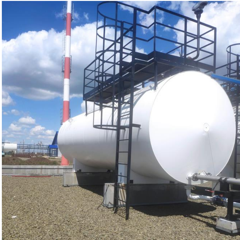
Рисунок 1 – Общий вид резервуара горизонтального стального цилиндрического РГС-50, зав. № 10
