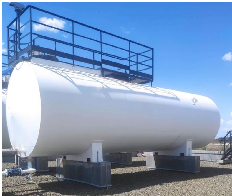
Рисунок 2 – Общий вид резервуара горизонтального стального цилиндрического РГС-50, зав. № 11
