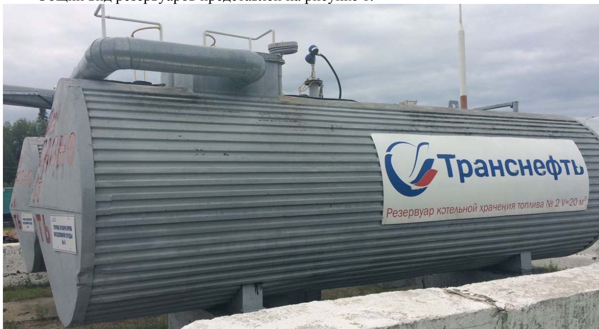
Рисунок 1 - Общий вид резервуаров стальных горизонтальных цилиндрических РГС-20 (17+3)
