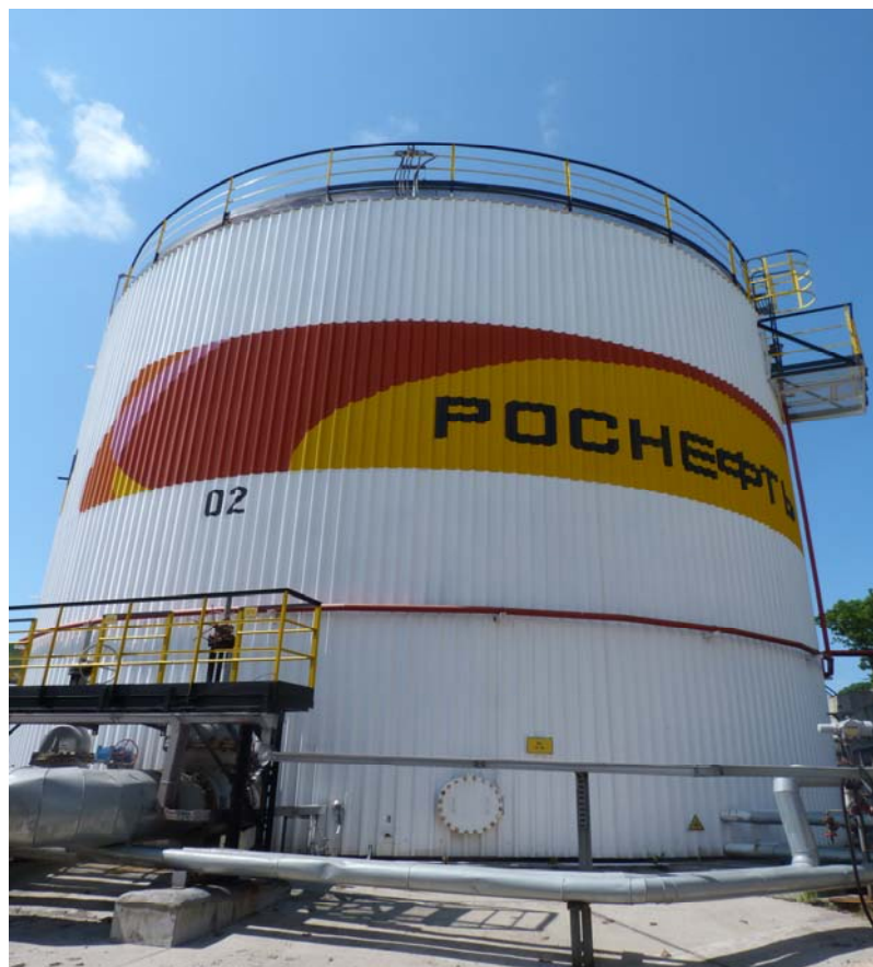
Рисунок 1 - Общий вид резервуара вертикального стального цилиндрического РВС-2000
