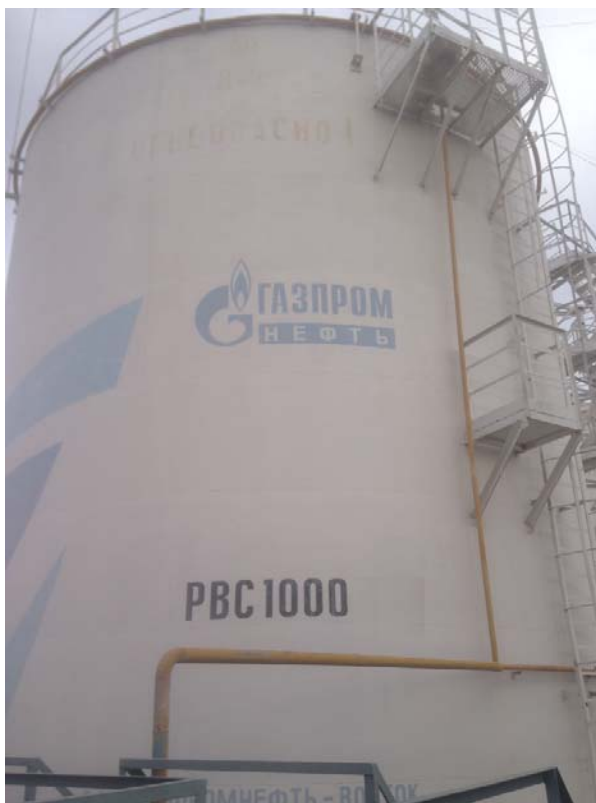
Рисунок 1 - Общий вид резервуара
