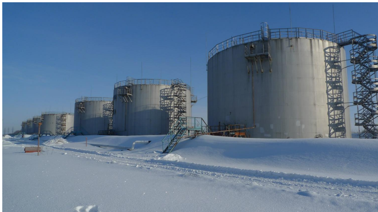
Рисунок 1 - Общий вид резервуаров РВС-3000
