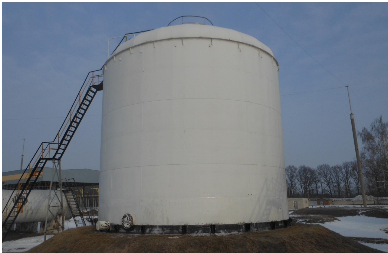
Рисунок 1 – Общий вид резервуара стального вертикального цилиндрического РВС-700
