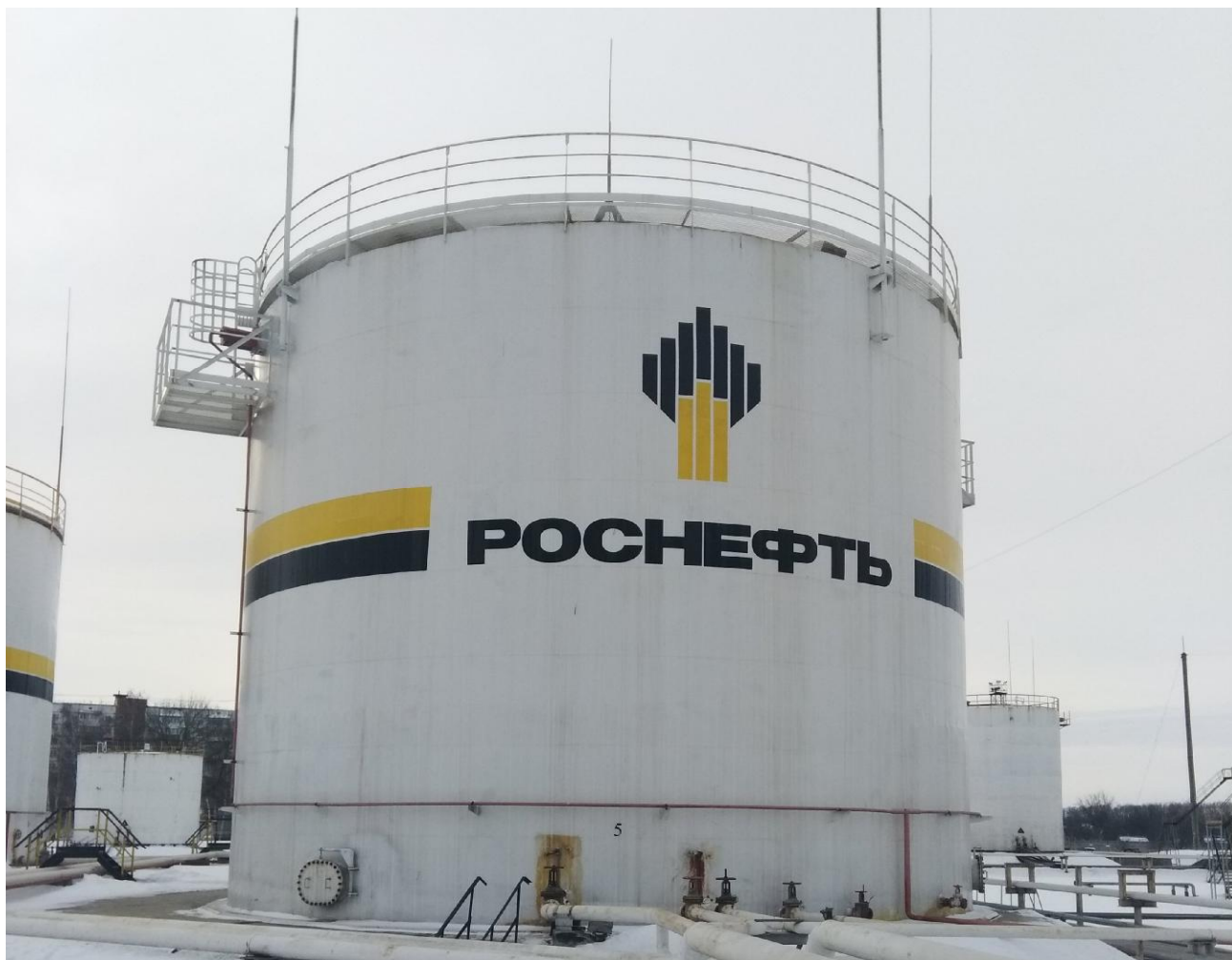
Рисунок 1 – Общий вид резервуара стального вертикального цилиндрического РВСП-2000
